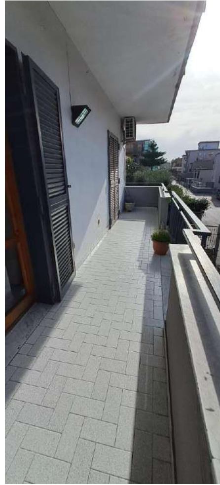
BALCONE (lato OVEST)
