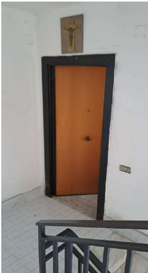
INGRESSO APPARTAMENTO (Primo piano) DAL VANO SCALA
