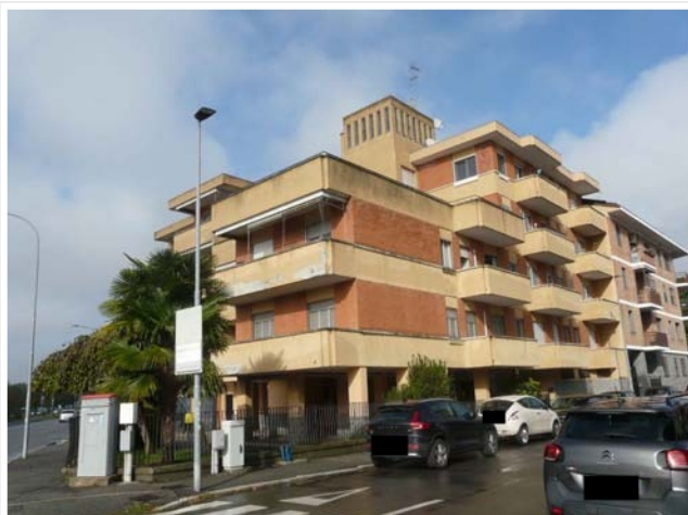
Foto n. 1- Facciata sud-ovest adiacente Via Luigi Galvani
