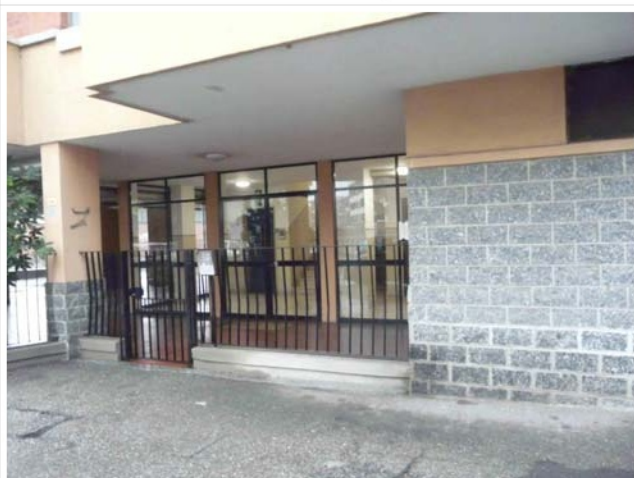
Foto n. 3 Ingresso Condominio "Superba" da Via Galvani
