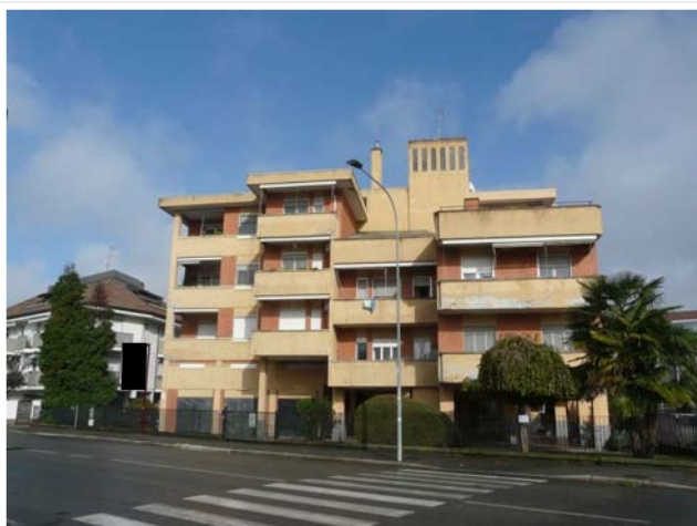
Foto n. 2 Facciata ovest adiacente Viale Kennedy
