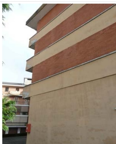
Foto n.4 Facciata nord verso la corte interna
