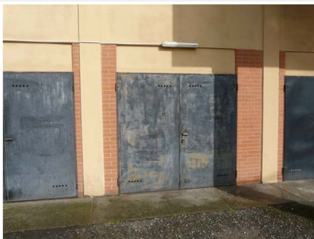
Foto 22 Porta autorimessa a piano terreno
