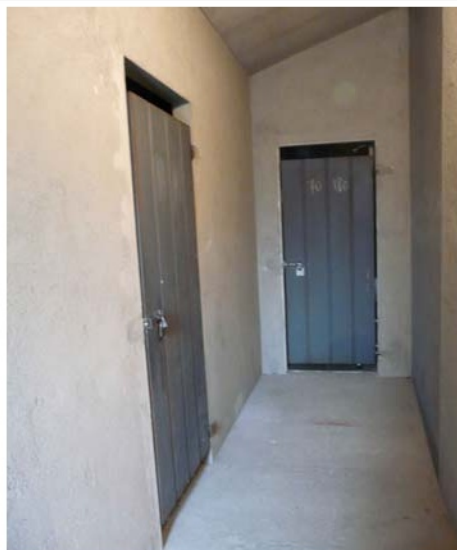
Foto 20 Soffitta uso cantina al piano terzo ammezzato
