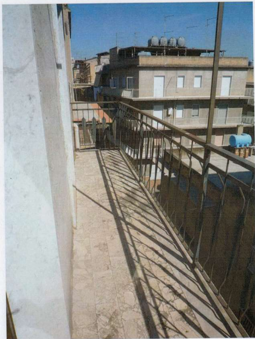
Balcone lato nord
