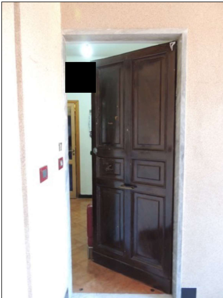
Foto 03 – l'accesso dal pianerottolo del sesto piano all'interno 17
