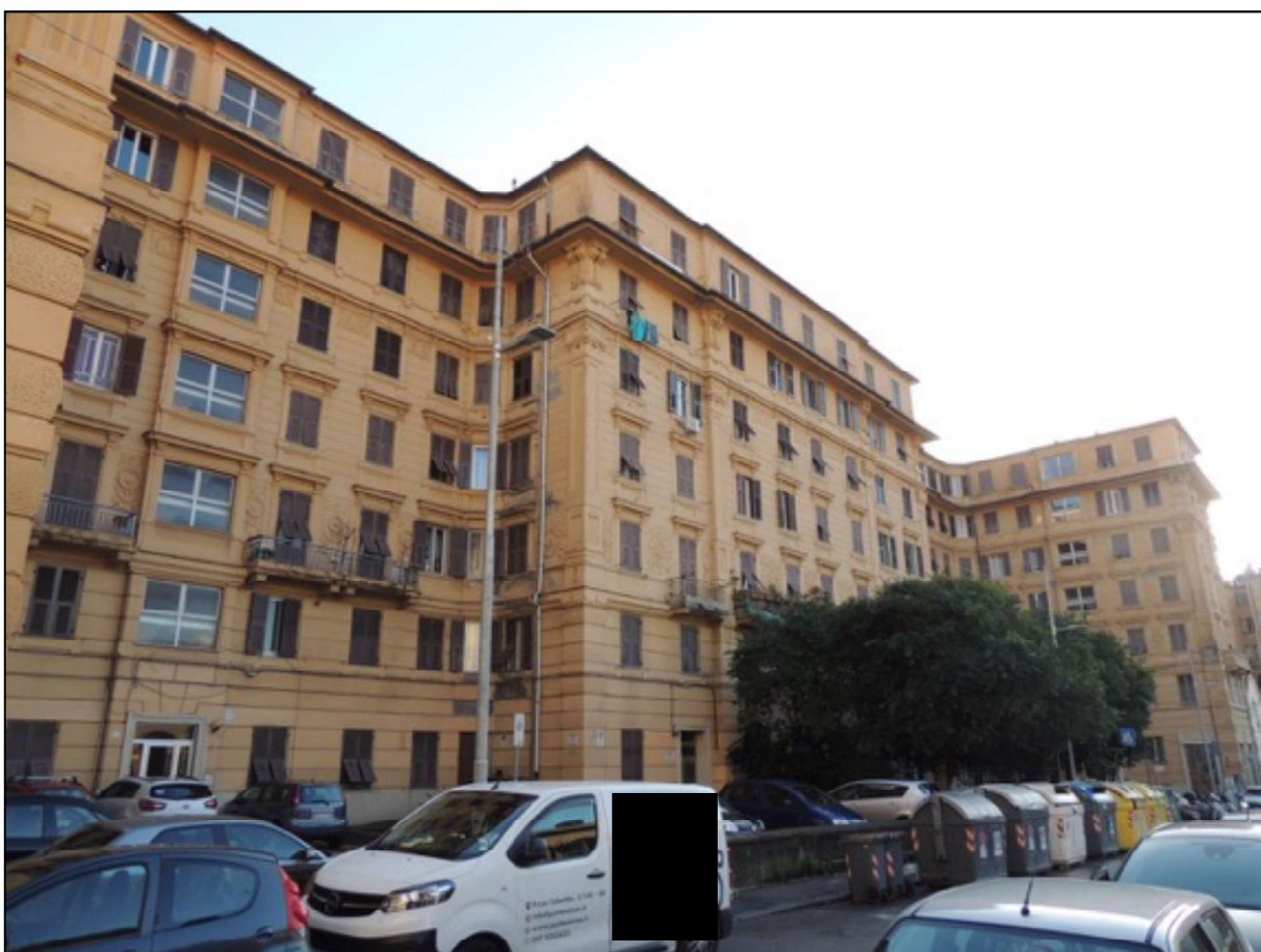
Foto 9 – il fabbricato visto da oriente verso occidente
