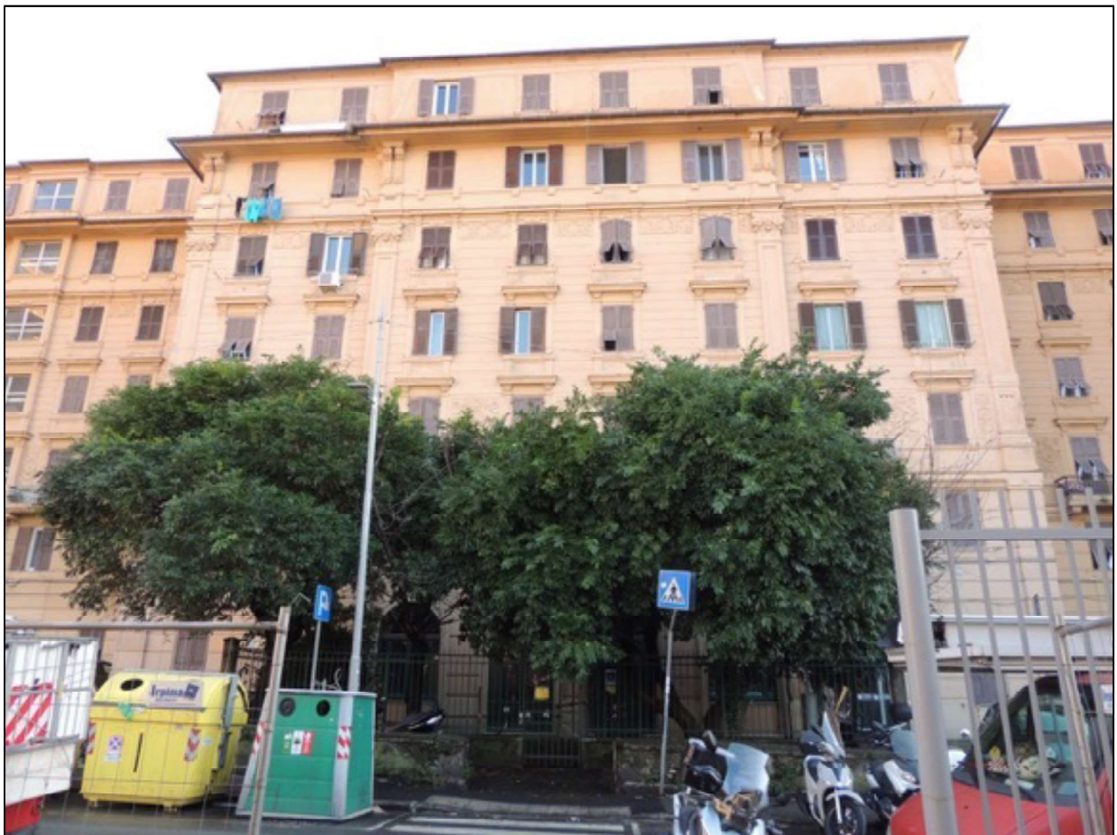
Foto 5 – vista frontale del settore centrale del fabbricato che al piano terreno e al piano primo ospita asilo e scuola elementare
