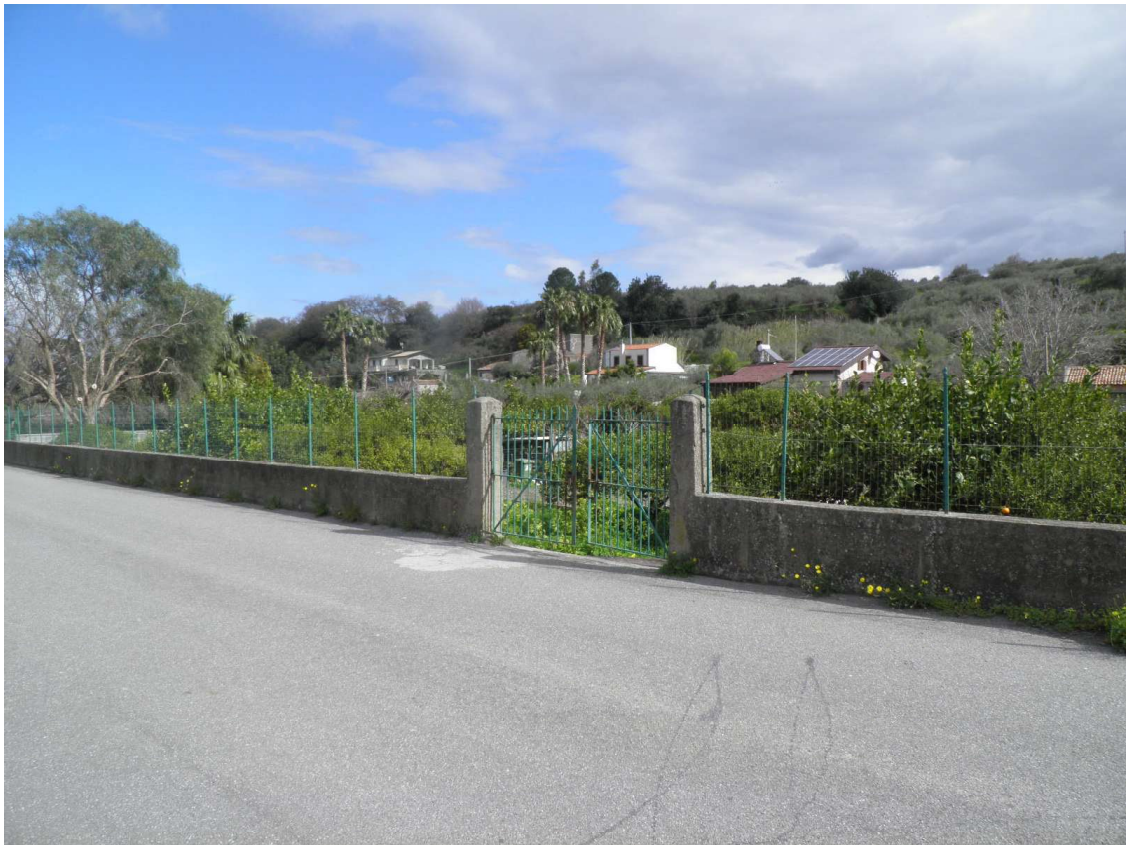
Vista sede stradale (ex particella 1633) e ingresso terreno (particella 1907)
