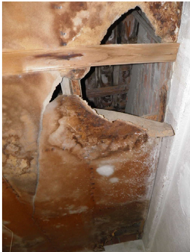
Vista del controsoffitto
