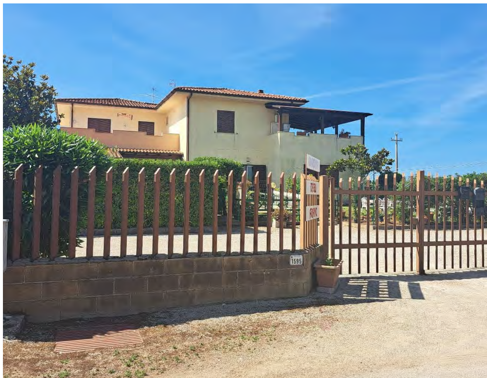
Immagine 1: immagini esterne del fabbricato dall'ingresso su Via Sugarelle
