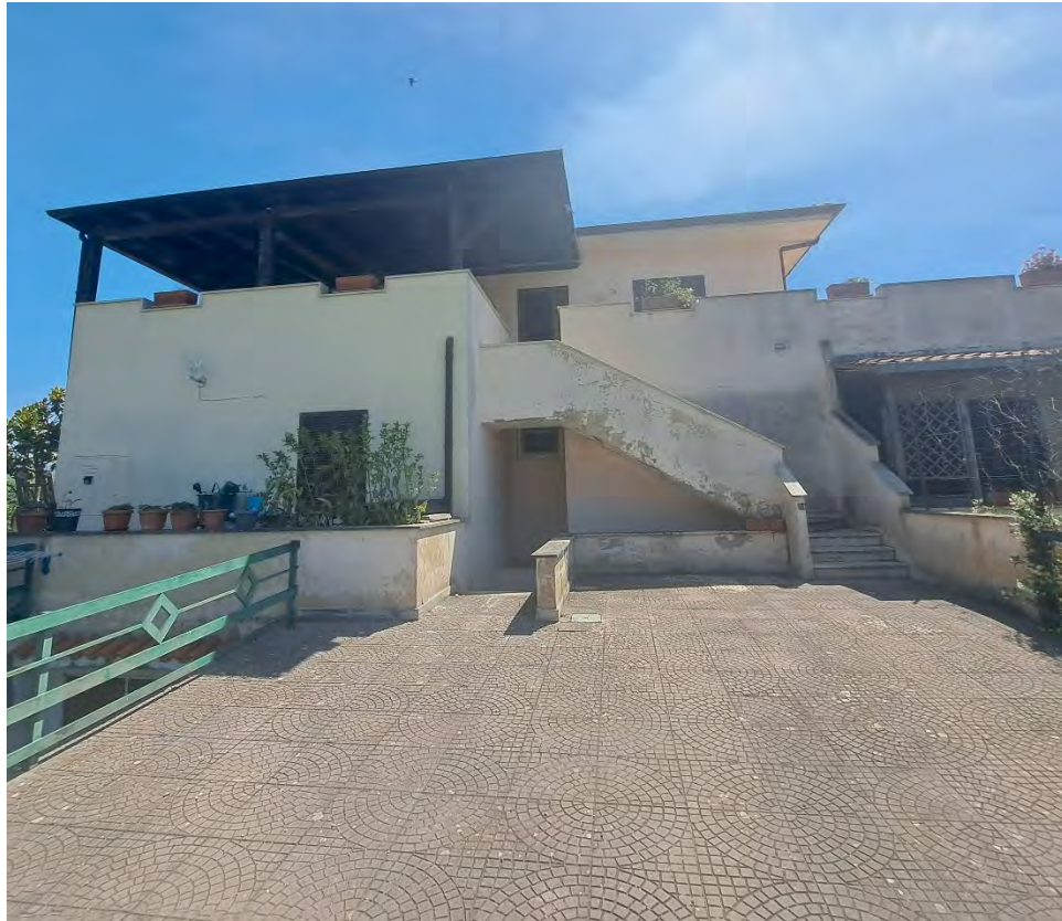
Immagine 3: Prospetto Ovest (scala di ingresso all'appartamento)
