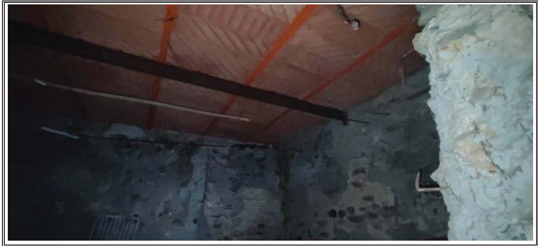
Foto n. 13 – Piano terra - Cantina
