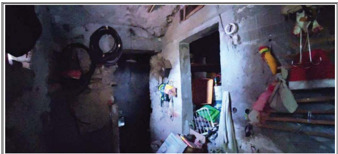
Foto n. 12 – Piano terra - Cantina
