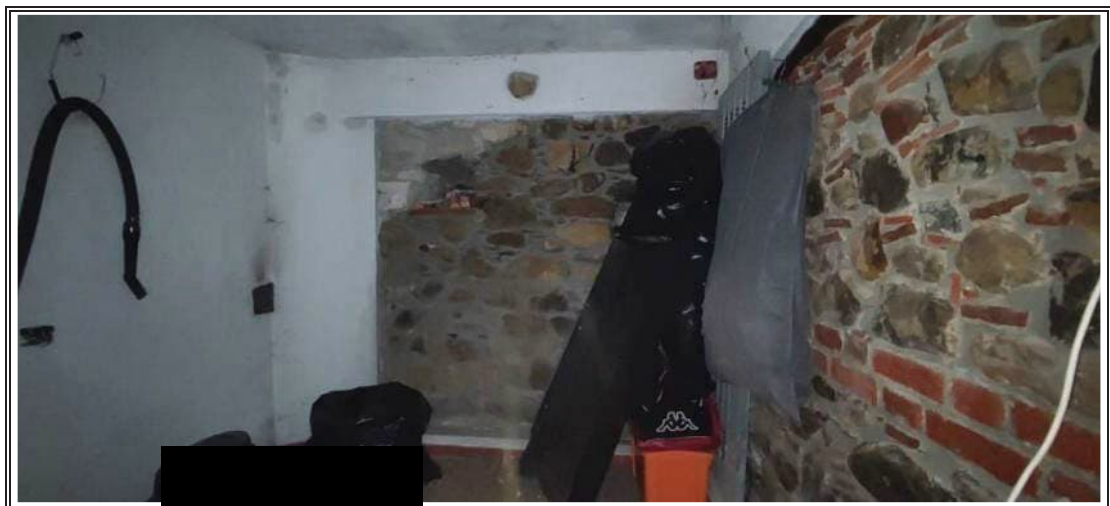
Foto n. 14 – Piano terra - Cantina
