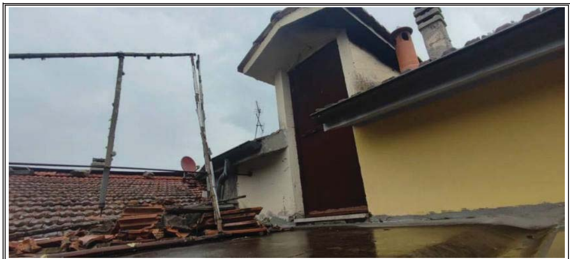
Foto n. 3 – Vista fabbricato – Ingresso ai vani sottotetto
