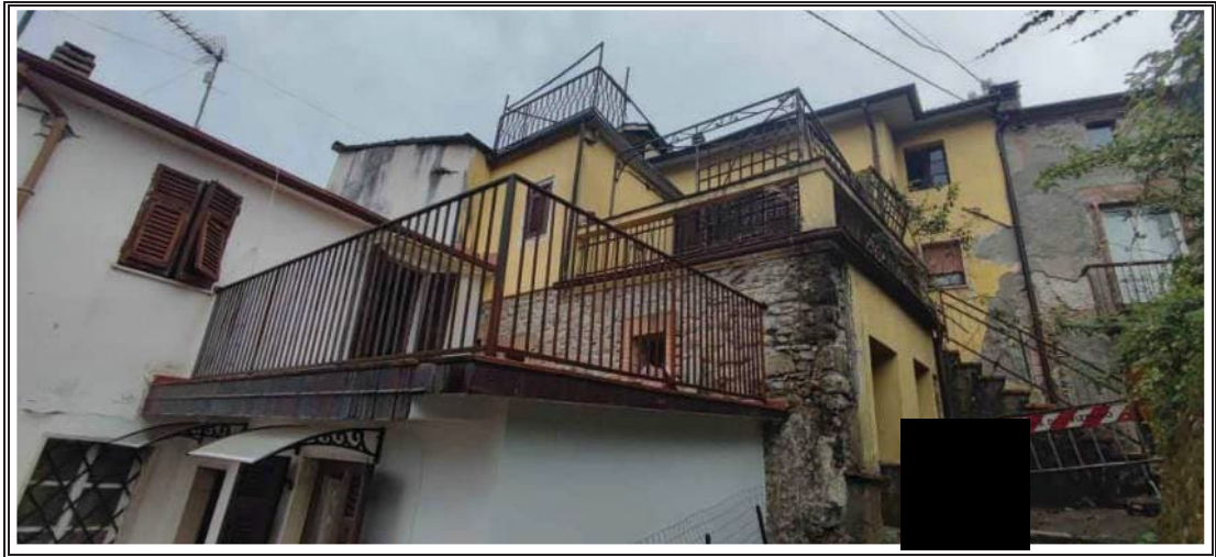
Foto n. 1 – Vista del fabbricato - angolo SUD/OVEST
