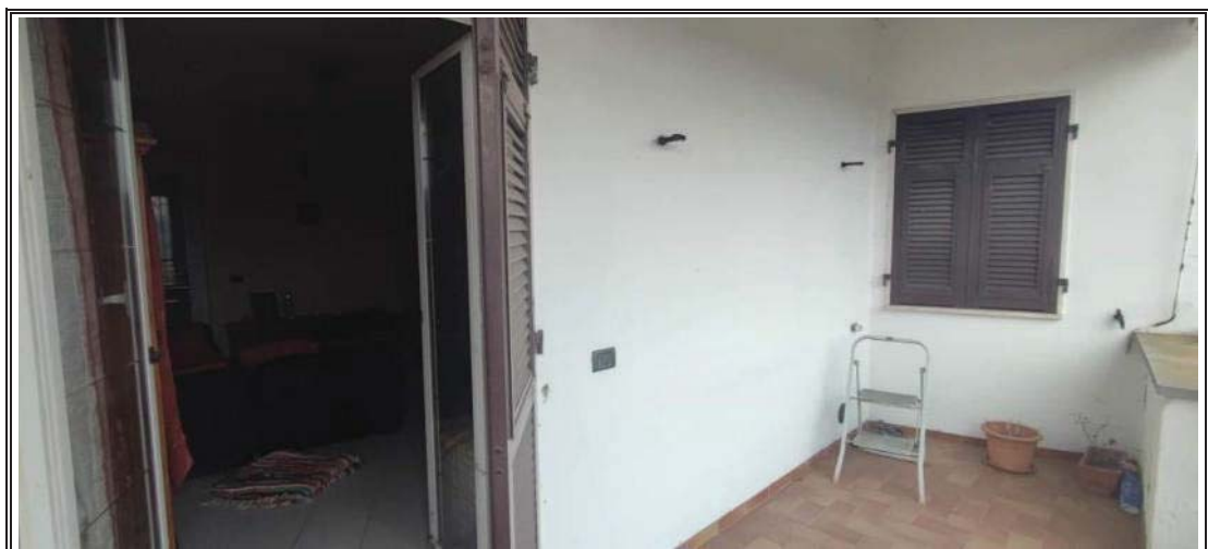
Foto n. 9 – Piano primo - Loggia
