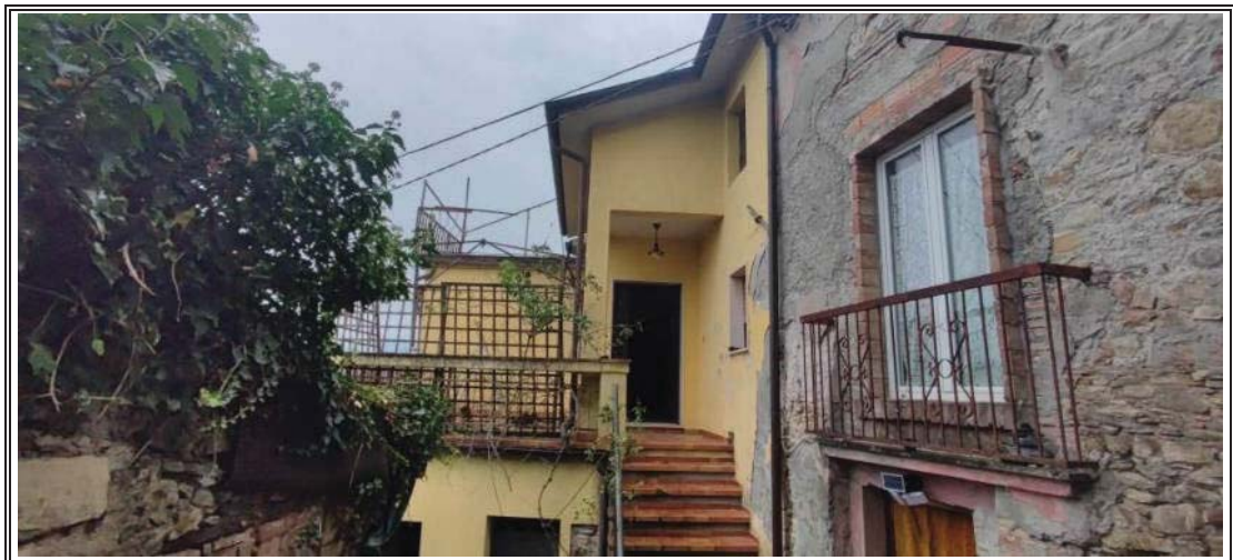
Foto n. 2 – Vista fabbricato – Lato SUD
