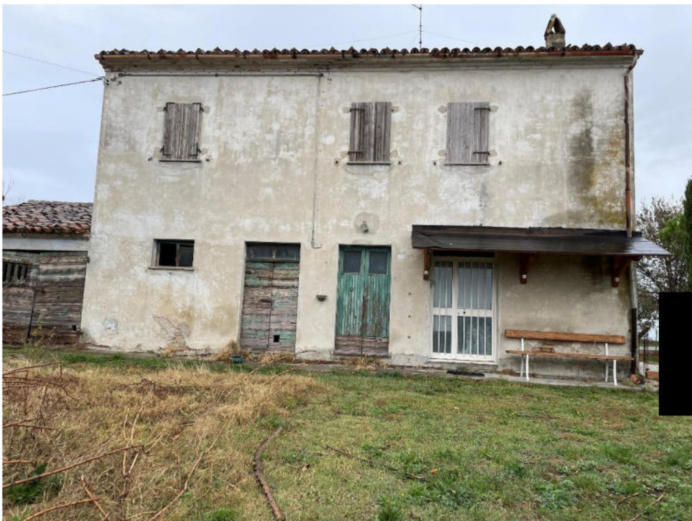
Foto n. 04 - Lotto 2 a – vista del rustico dallo scoperto esclusivo comune alla villetta in costruzione
