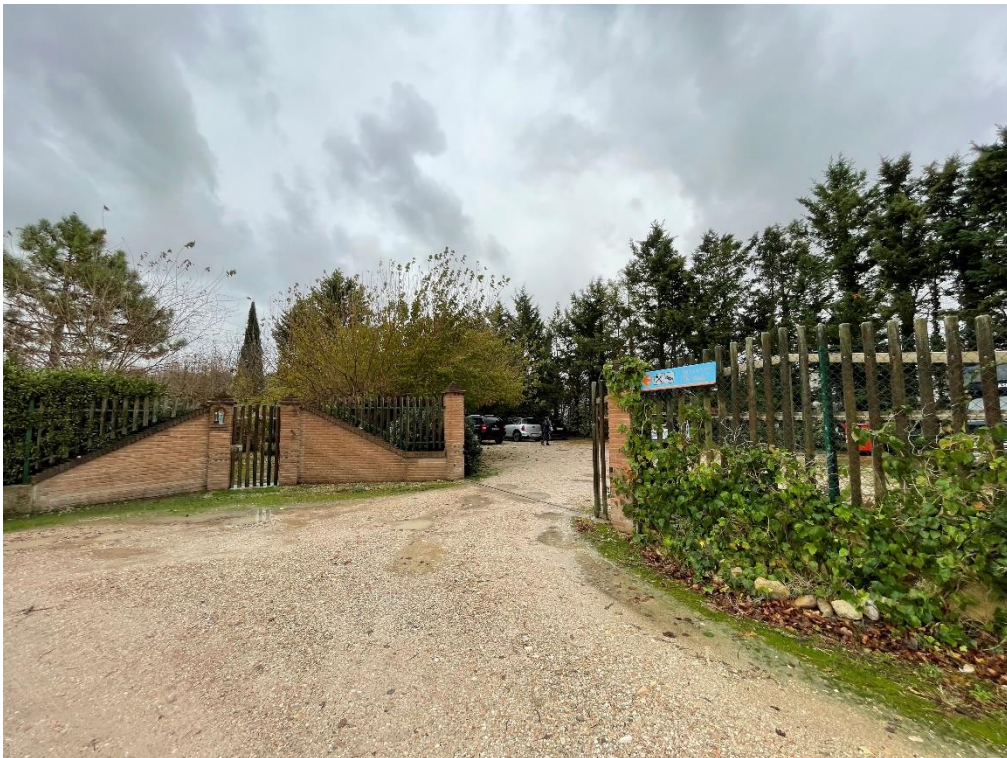
Foto n. 19 - Lotto 3 – vista dell'ingresso all'agriturismo
