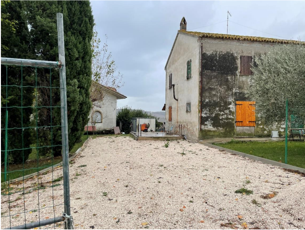
Foto n. 05 - Lotto 2 a – vista del rustico dall'ingresso carrabile al lotto, da via Palazzo
