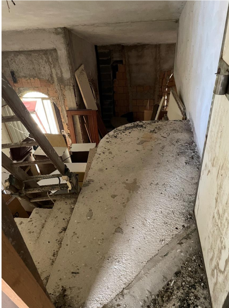
Foto n. 17 - Lotto 2 b – vista parziale della scala interna (collegamento piano terra e primo) della villetta in costruzione
