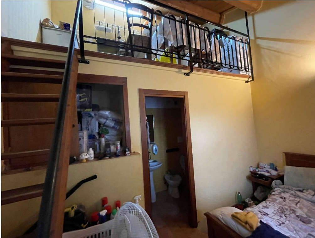
Foto n. 23 - Lotto 3 – vista di una delle camere dell’agriturismo, nelle quali è stato ricavato un soppalco con angolo cottura sulla “copertura” del bagno
