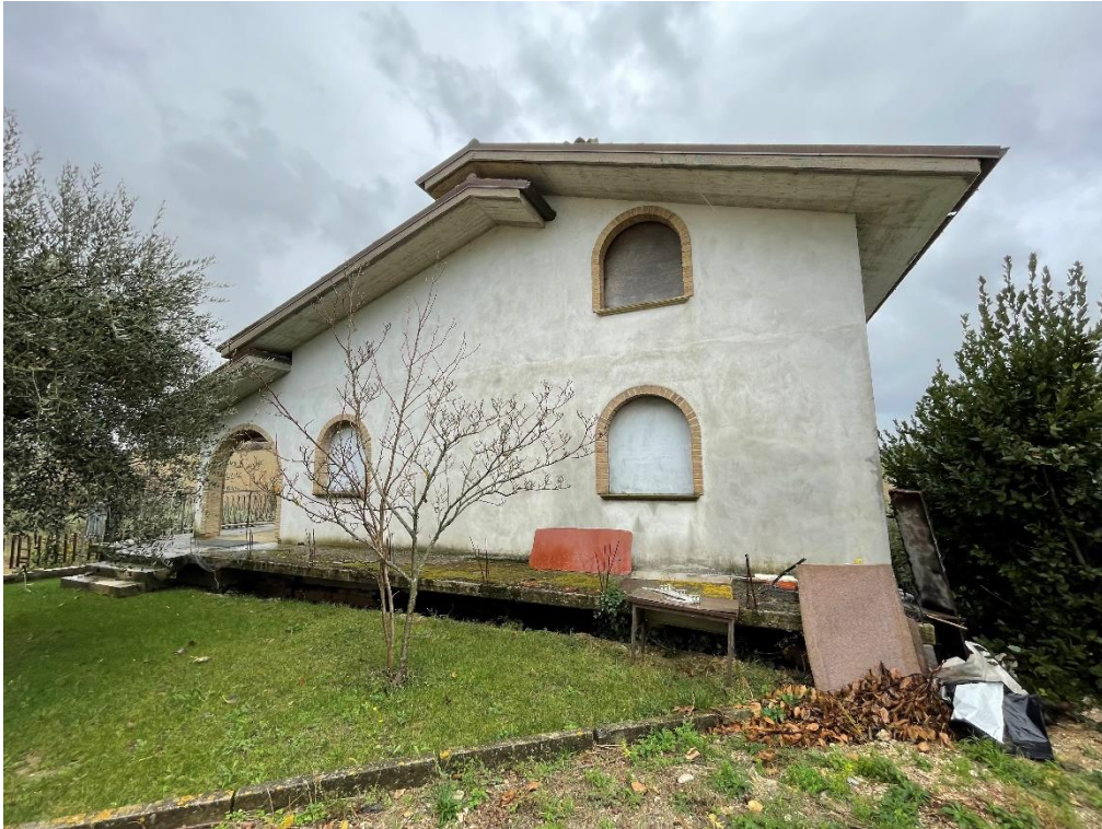
Foto n. 09 - Lotto 2 b – vista del fronte della villetta in costruzione dallo scoperto comune con il rustico
