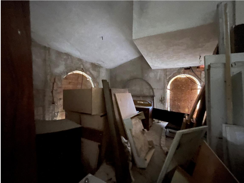
Foto n. 16 - Lotto 2 b – vista parziale del soggiorno della villetta in costruzione
