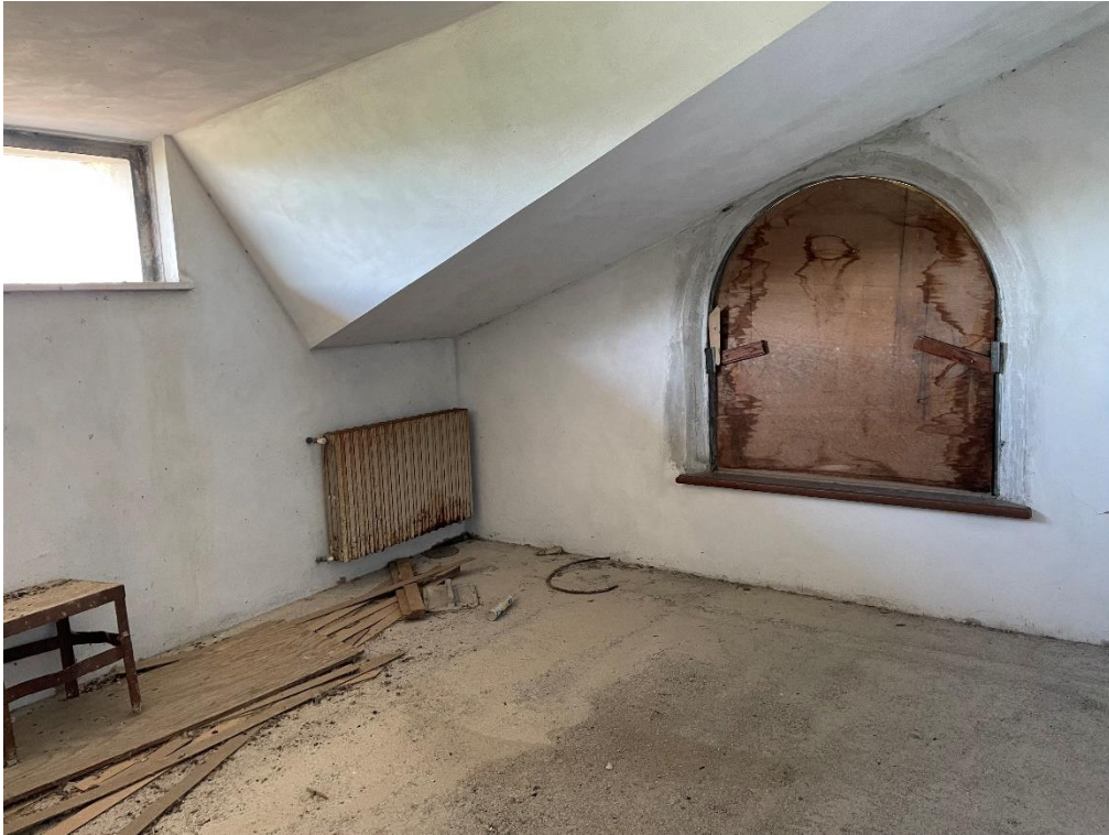
Foto n. 18 - Lotto 2 b – vista parziale di un vano al piano primo sottotetto
