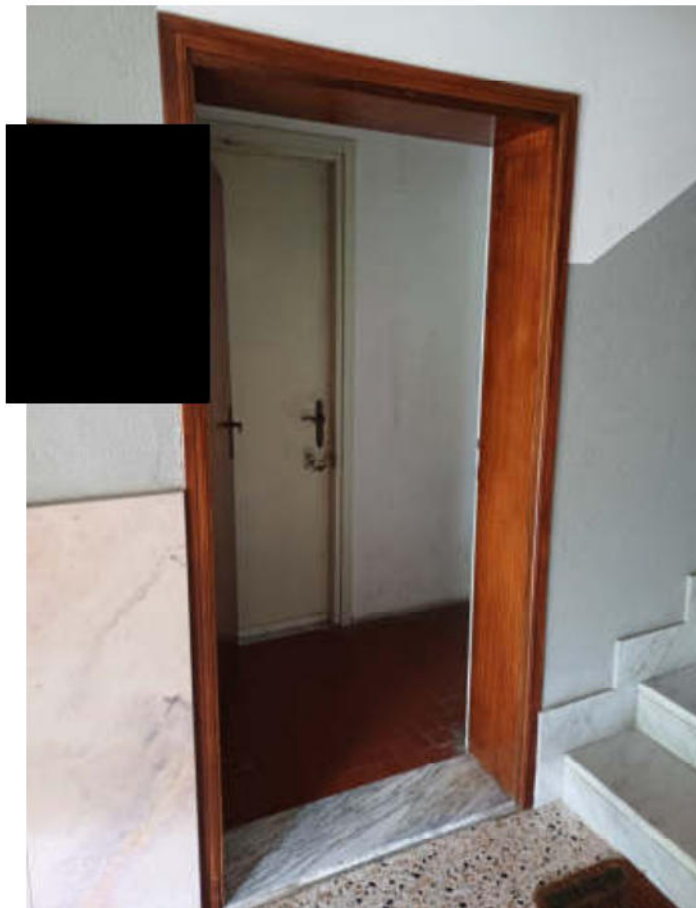
14 - Accesso corridoio comune
