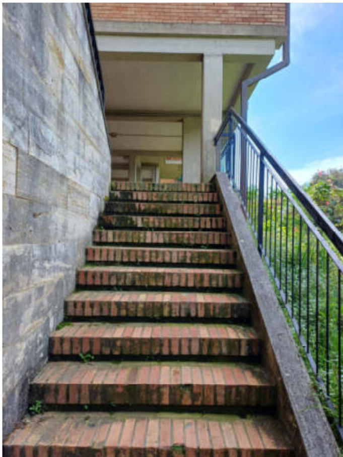
5 - Scala di accesso
