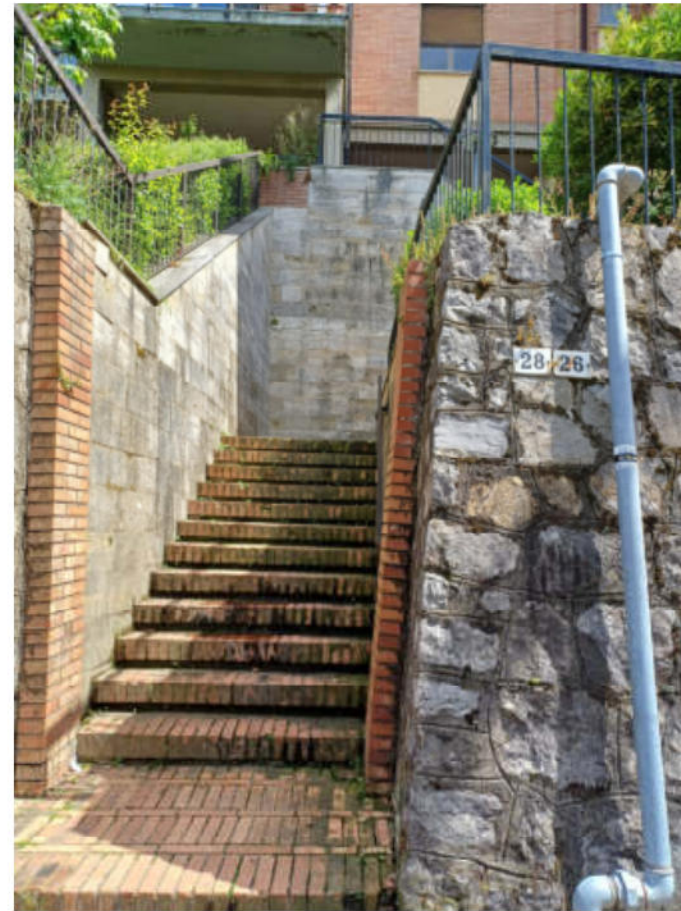
3 - Scala di accesso
