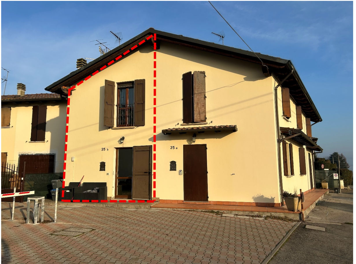
Ripresa fronti sud est edificio
