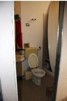
SERVIZIO IGIENICO UBICATO NELLA PORZIONE AD USO CANTINA
