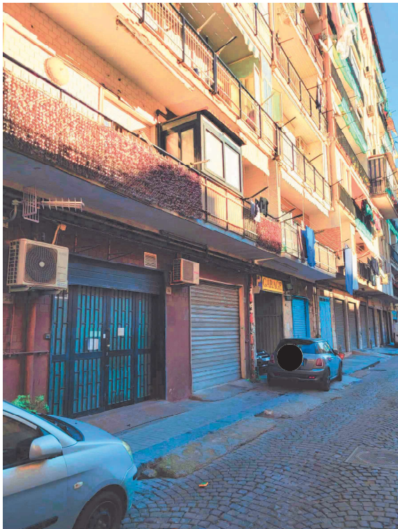
Vista generale vano di accesso all'immobile
