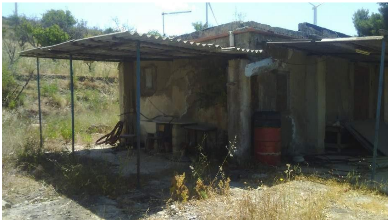
Foto 10- Prospetto Nord fabbricato identificato al Fg. 131 part. 201 sub 2
