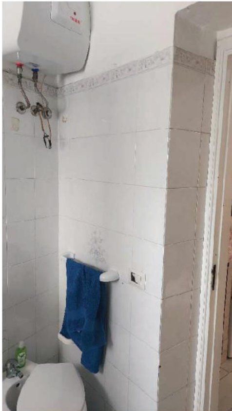
-Foto n.11- segue bagno
