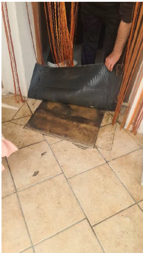
-Foto n. 6 botola cisterna acqua
