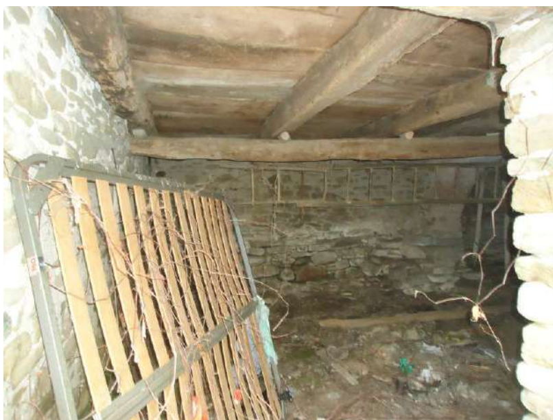
Locale di sgombero con legnaia indicata in planimetria catastale Foto n° 32
