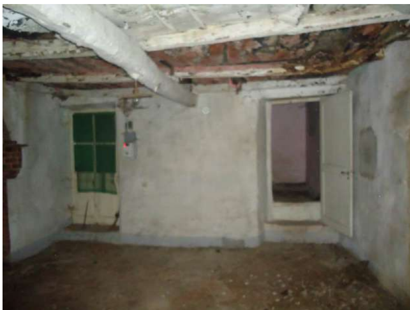
Locale di ingresso Foto n° 42
