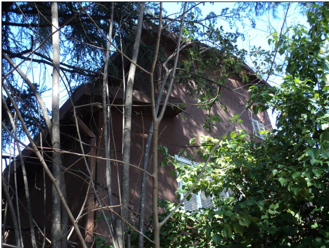
Foto N.3: Prospetto Est della villa dove ricadono gli immobili oggetto di stima.
