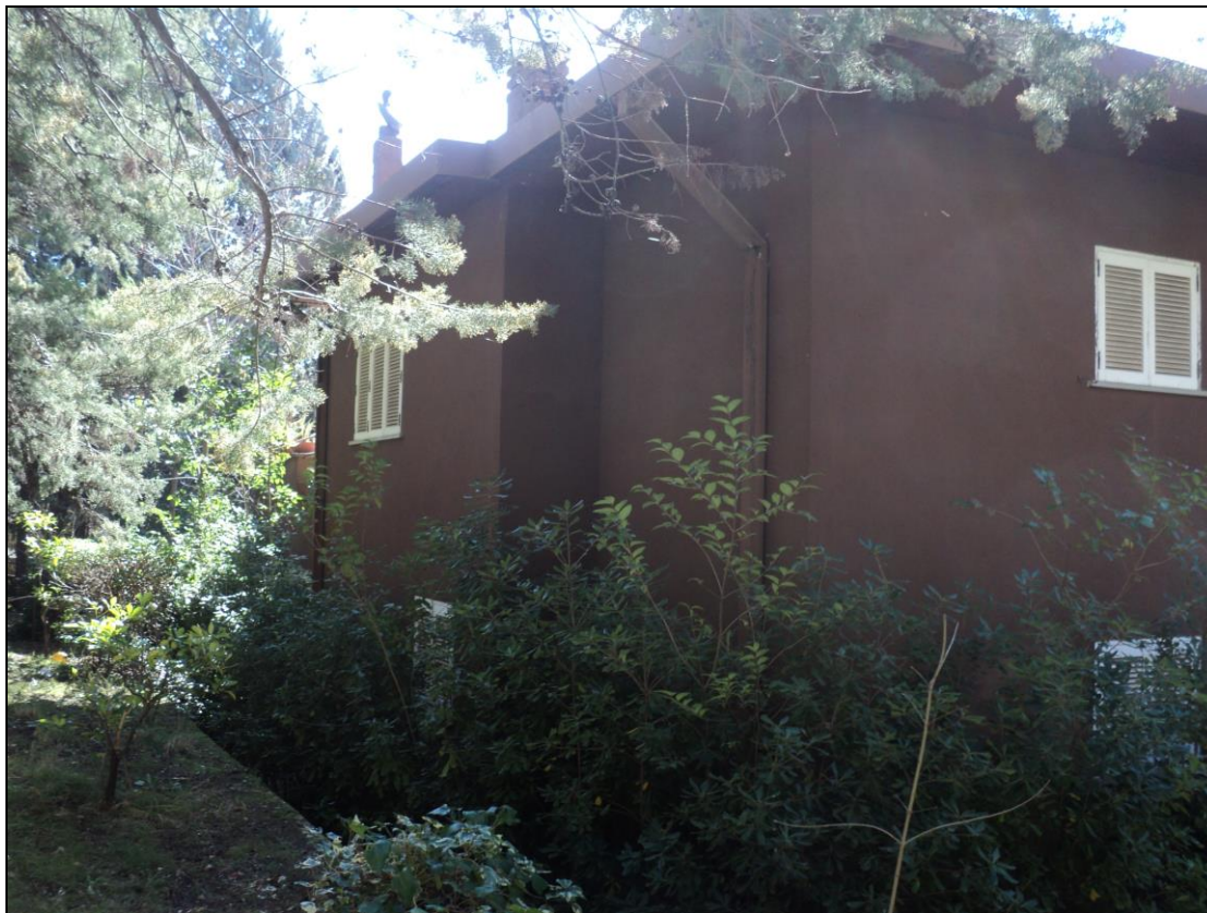
Foto N.1: Prospetto Nord della villa dove ricadono gli immobili oggetto di stima.
