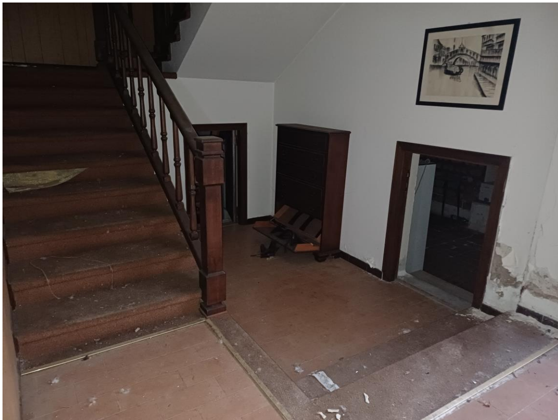
Foto n. 18: Corpo scala e disimpegno con accesso ai locali seminterrati al piano terra Lotto n. 3
