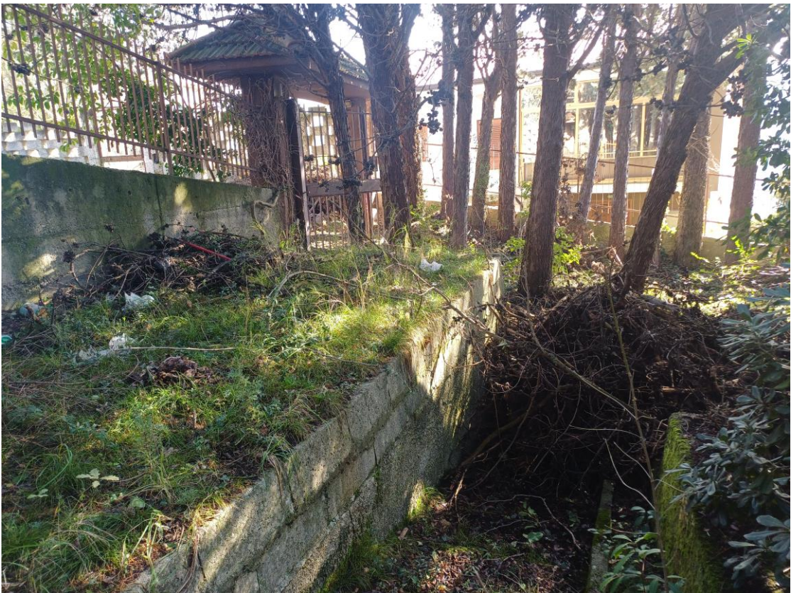
Foto n. 4: Ingresso dalla corte esterna del fabbricato
