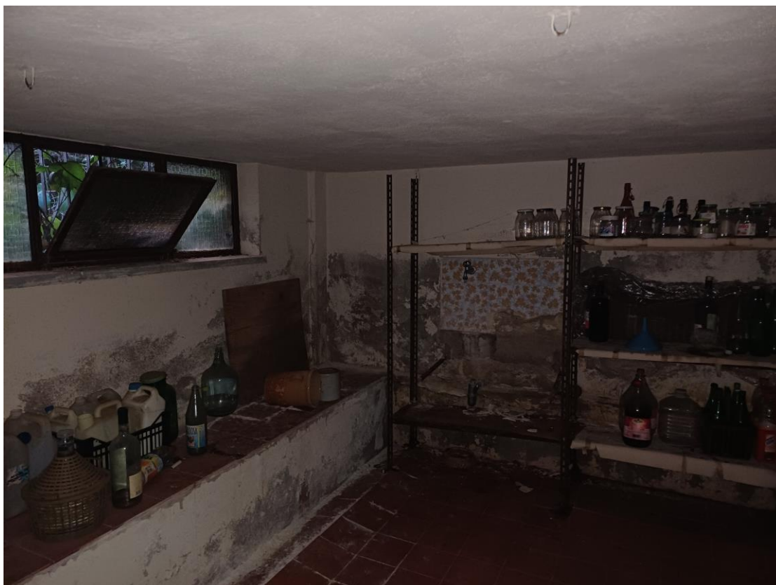
Foto n. 19: Cantina 1 al piano seminterrato Lotto n. 3
