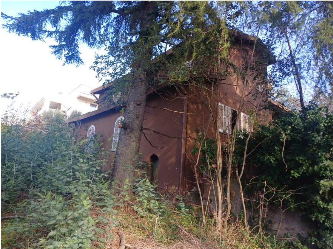
Foto n. 1: Angolo Sud – Est del fabbricato
