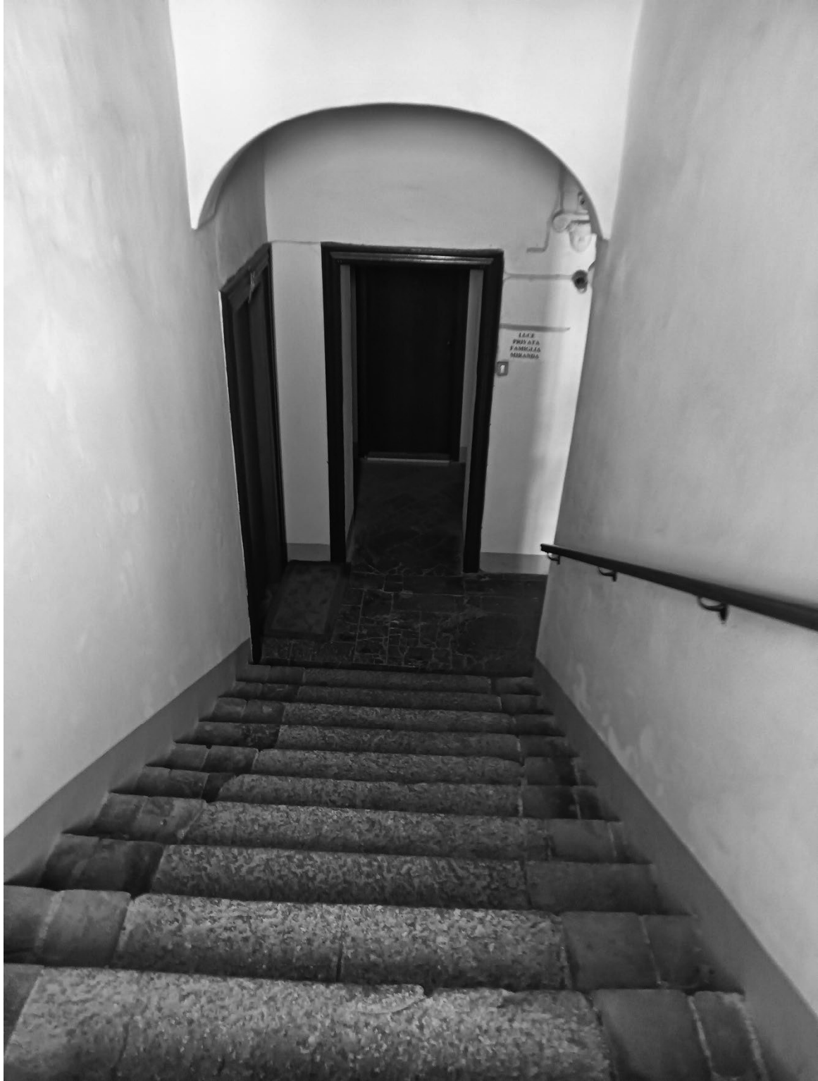
Fg.12 Mapp.226 Sub.701 – Scala di accesso
