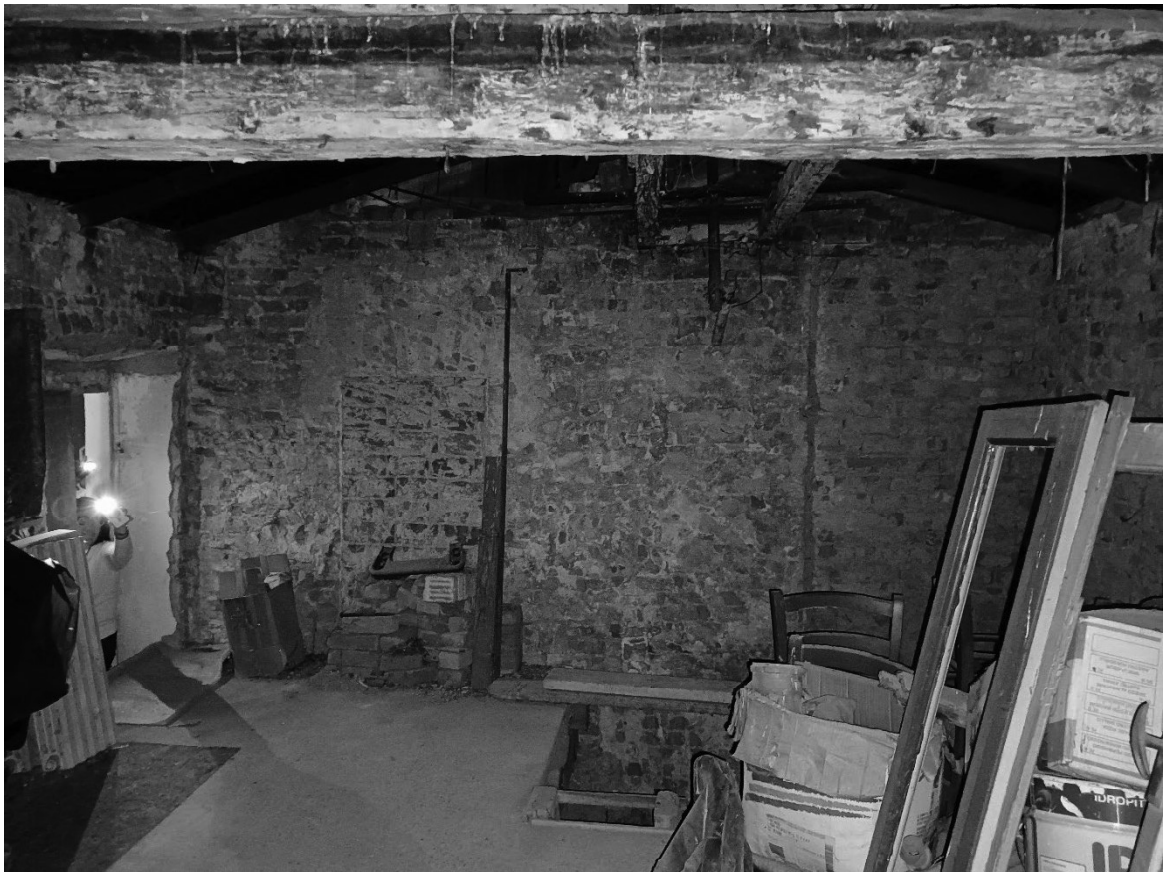
Fg.12 Mapp.226 Sub.701 – Sottotetto
