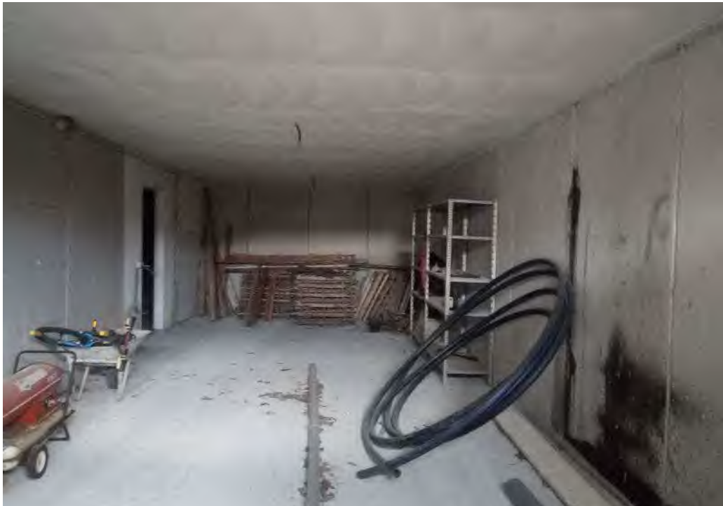
FOTO - vista interno piano seminterrato - cantina
