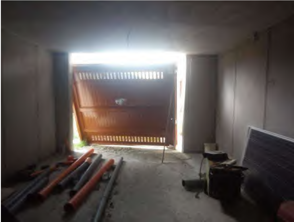
FOTO - vista interno piano seminterrato - cantina
