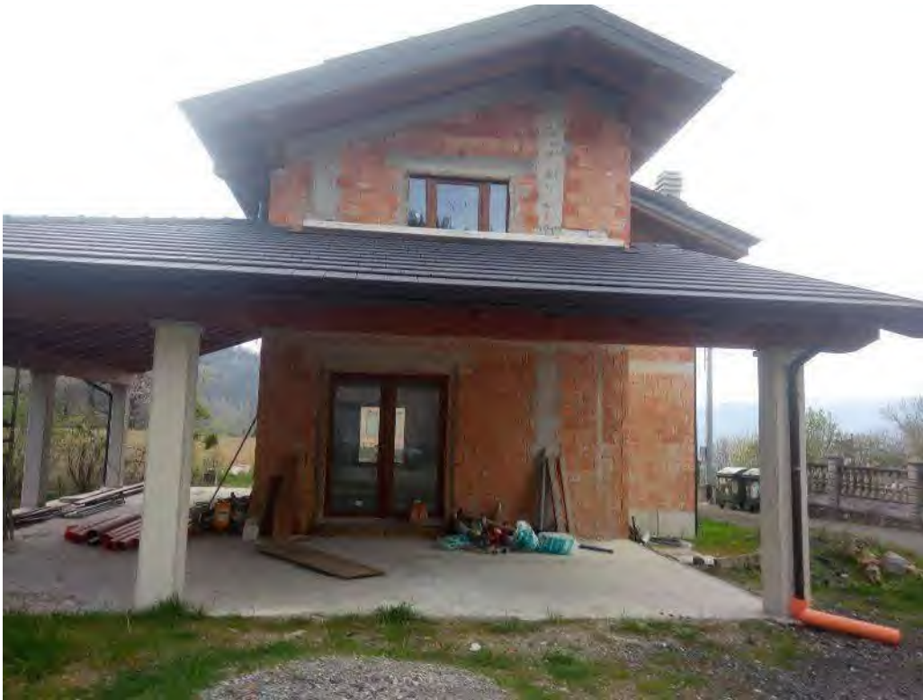
FOTO - vista prospetto est
