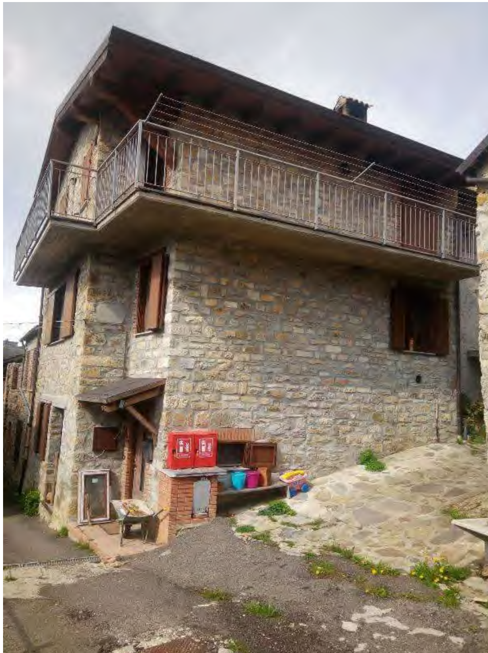
FOTO - vista prospetto sud
