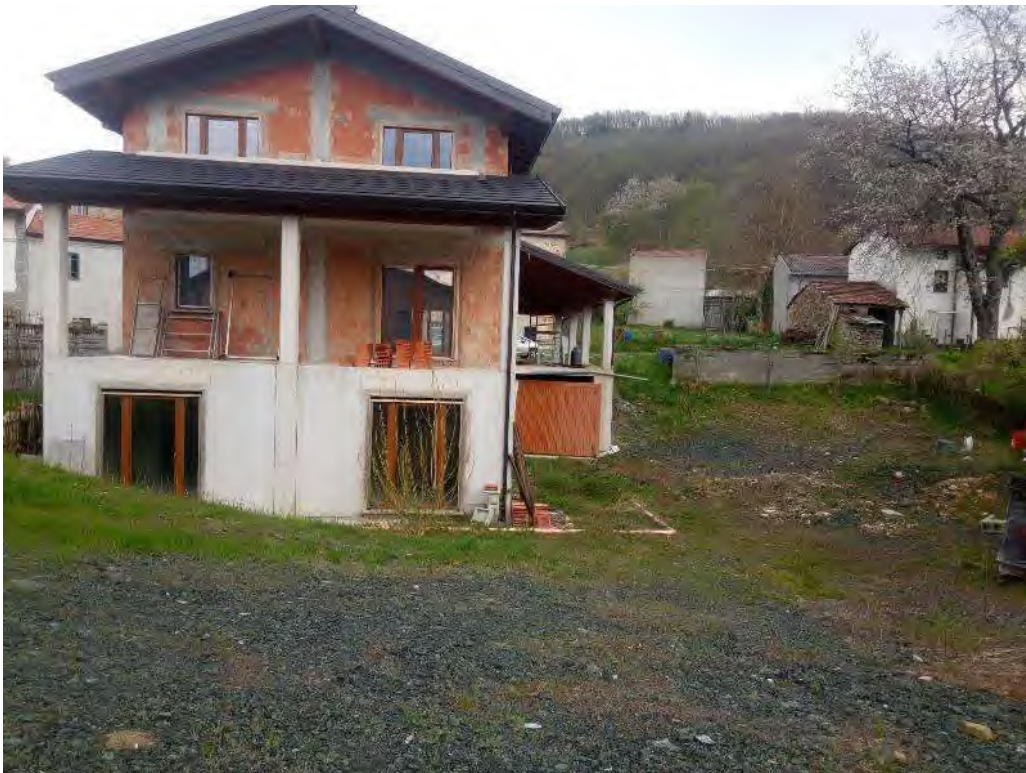
FOTO - vista prospetto ovest
