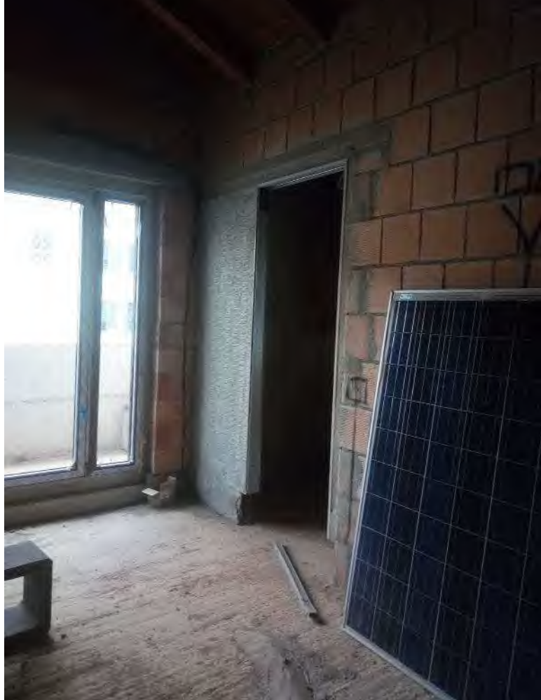
FOTO - vista interno piano primo – camera di fianco wc.
