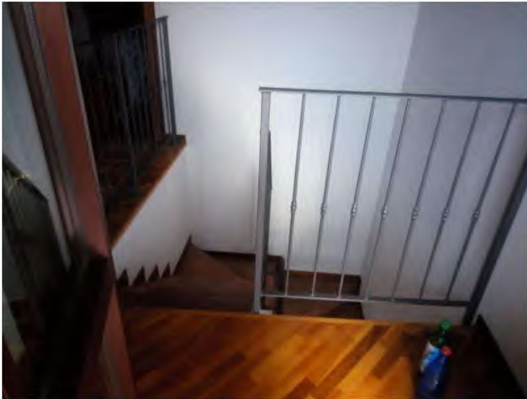
FOTO - vista interno piano secondo – vano scala
