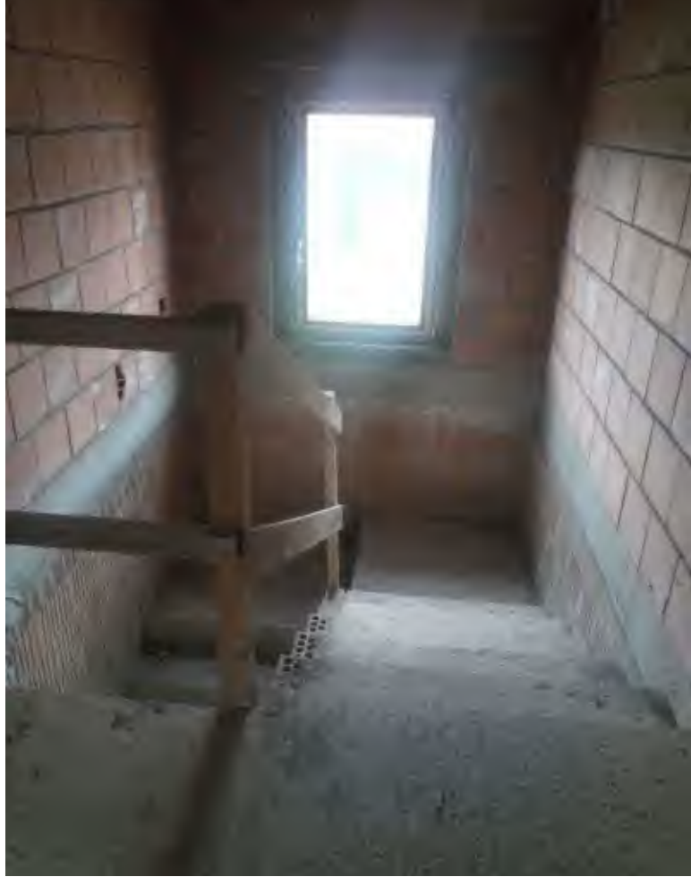
FOTO - vista interno piano primo – vano scala
