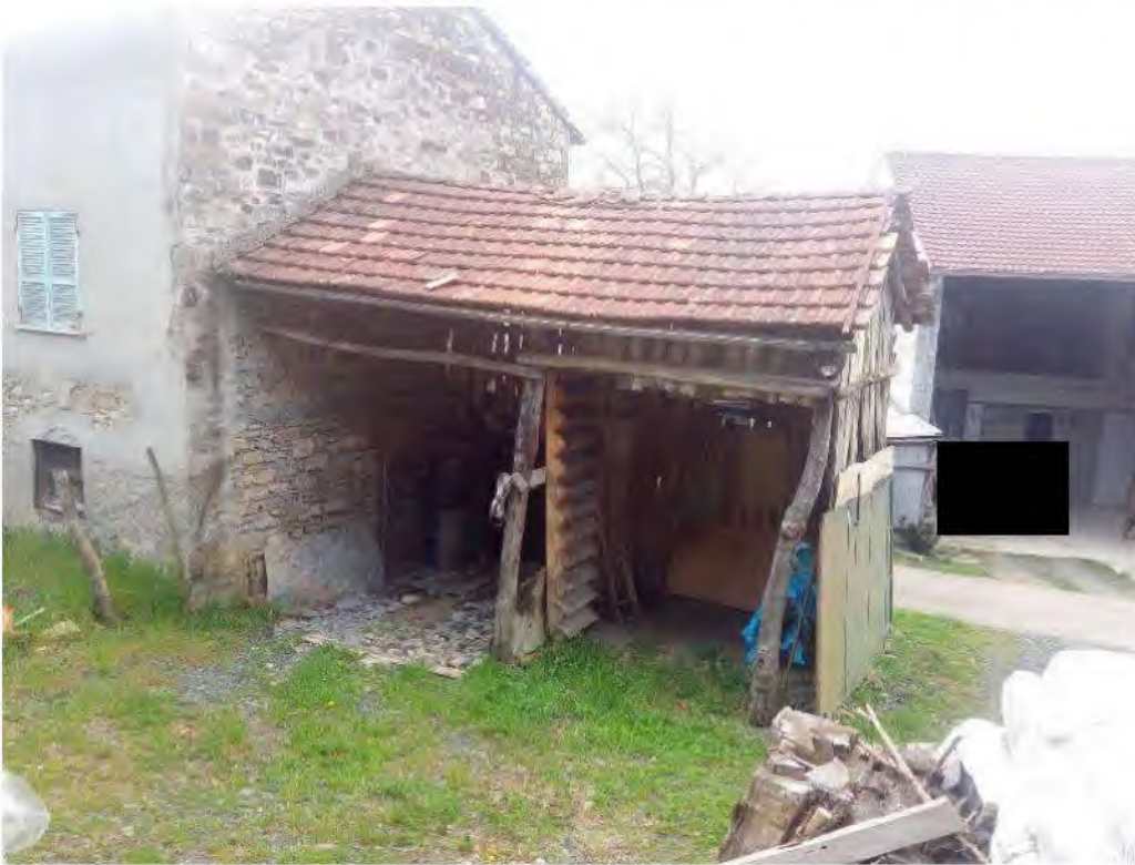
FOTO - vista prospetto est
