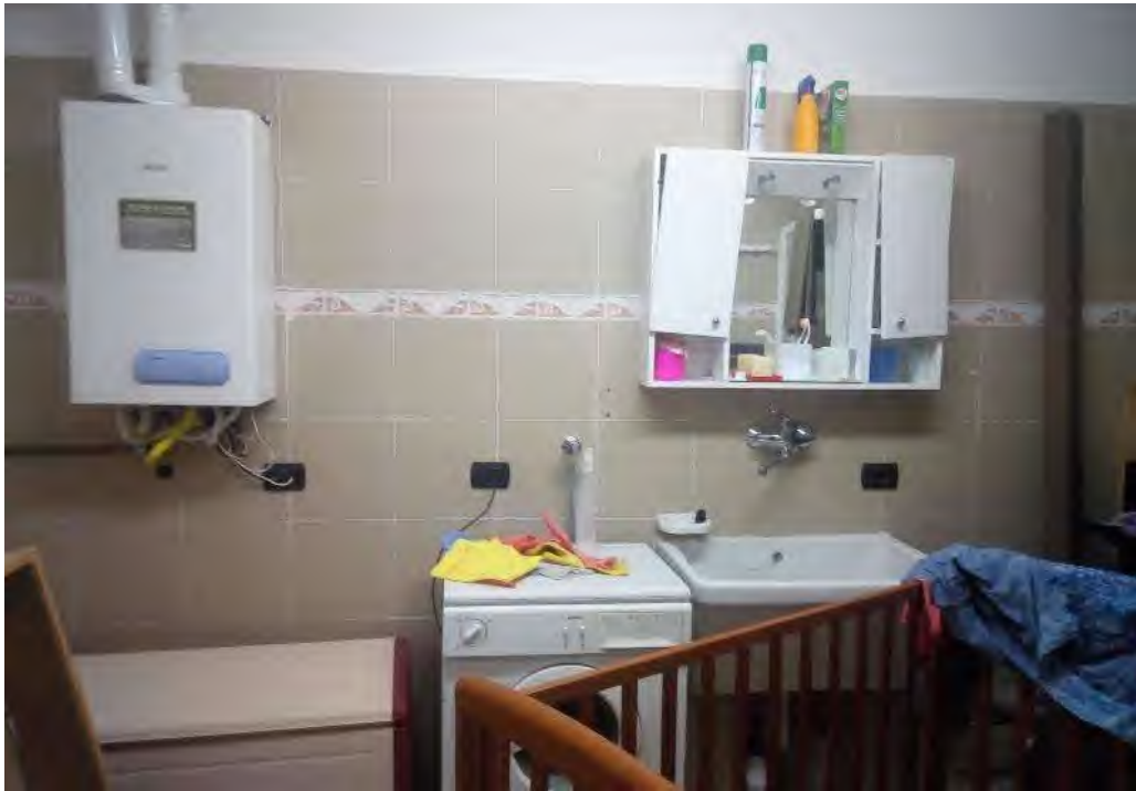
FOTO - vista interno piano terra - lavanderia
