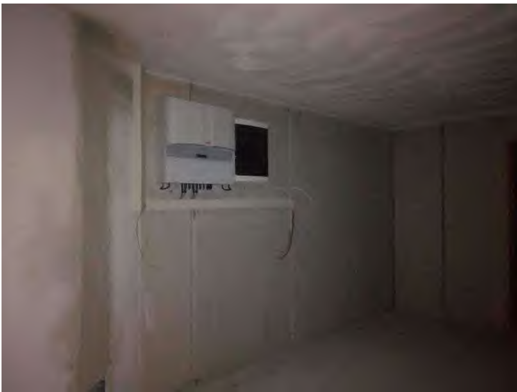
FOTO - vista interno piano seminterrato - cantina
