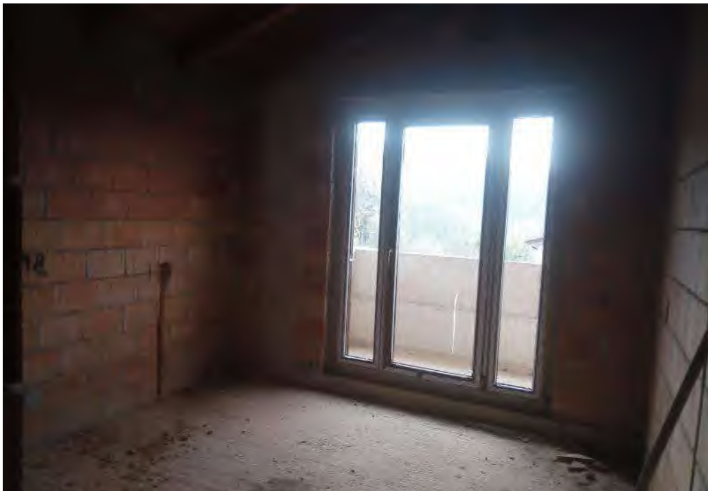
FOTO - vista interno piano primo – camera
