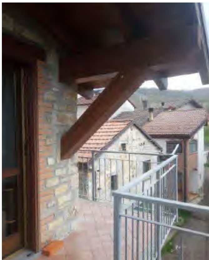
FOTO - vista interno piano secondo - balcone
