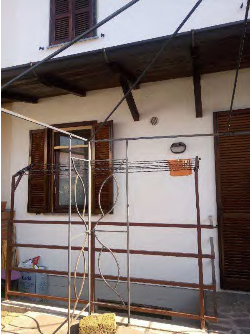
FOTO - vista prospetto sud
