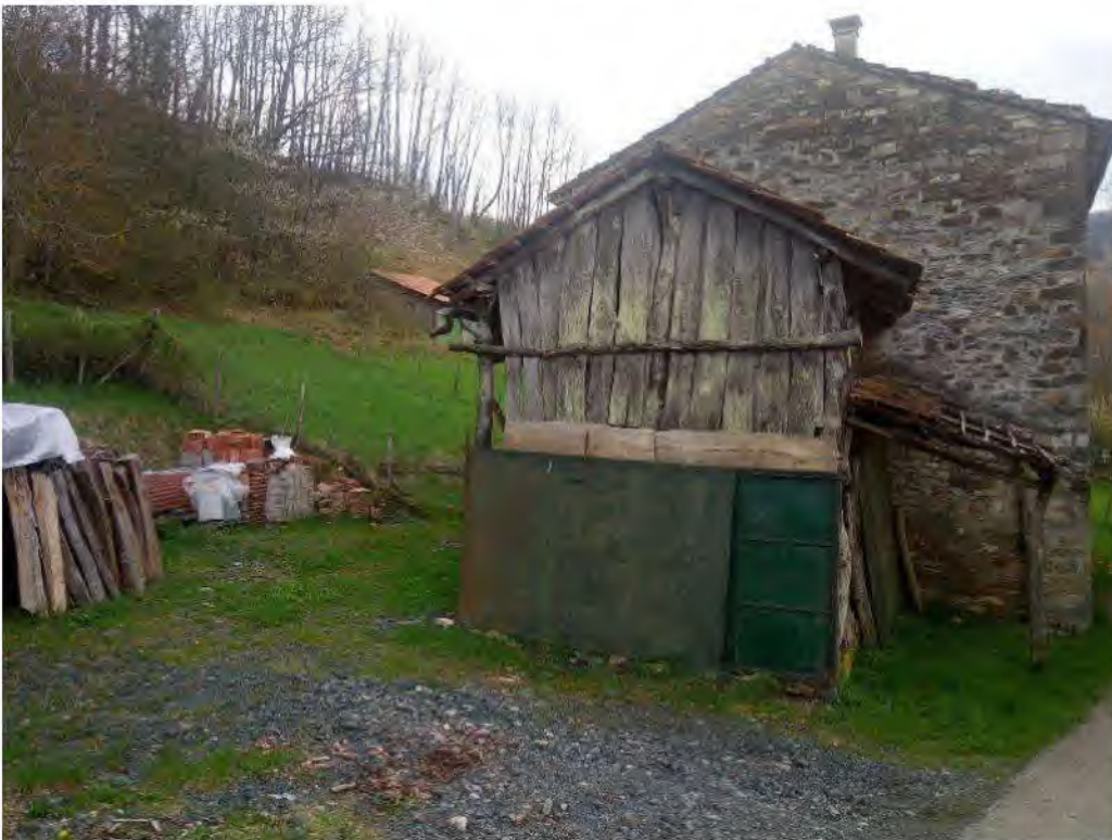
FOTO - vista prospetto nord
