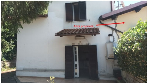
Foto n. 2 – Vista del retro dell'immobile – Ingresso
