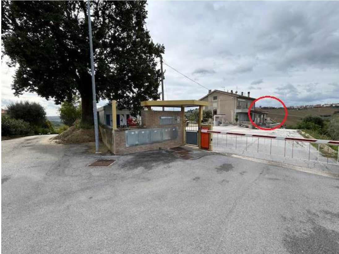
VISTA INGRESSO ALLA PROPRIETA'
