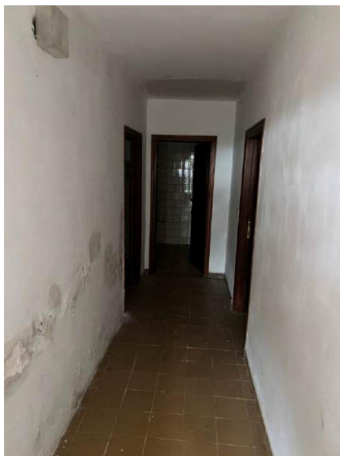
INGRESSO – Piano Terra
