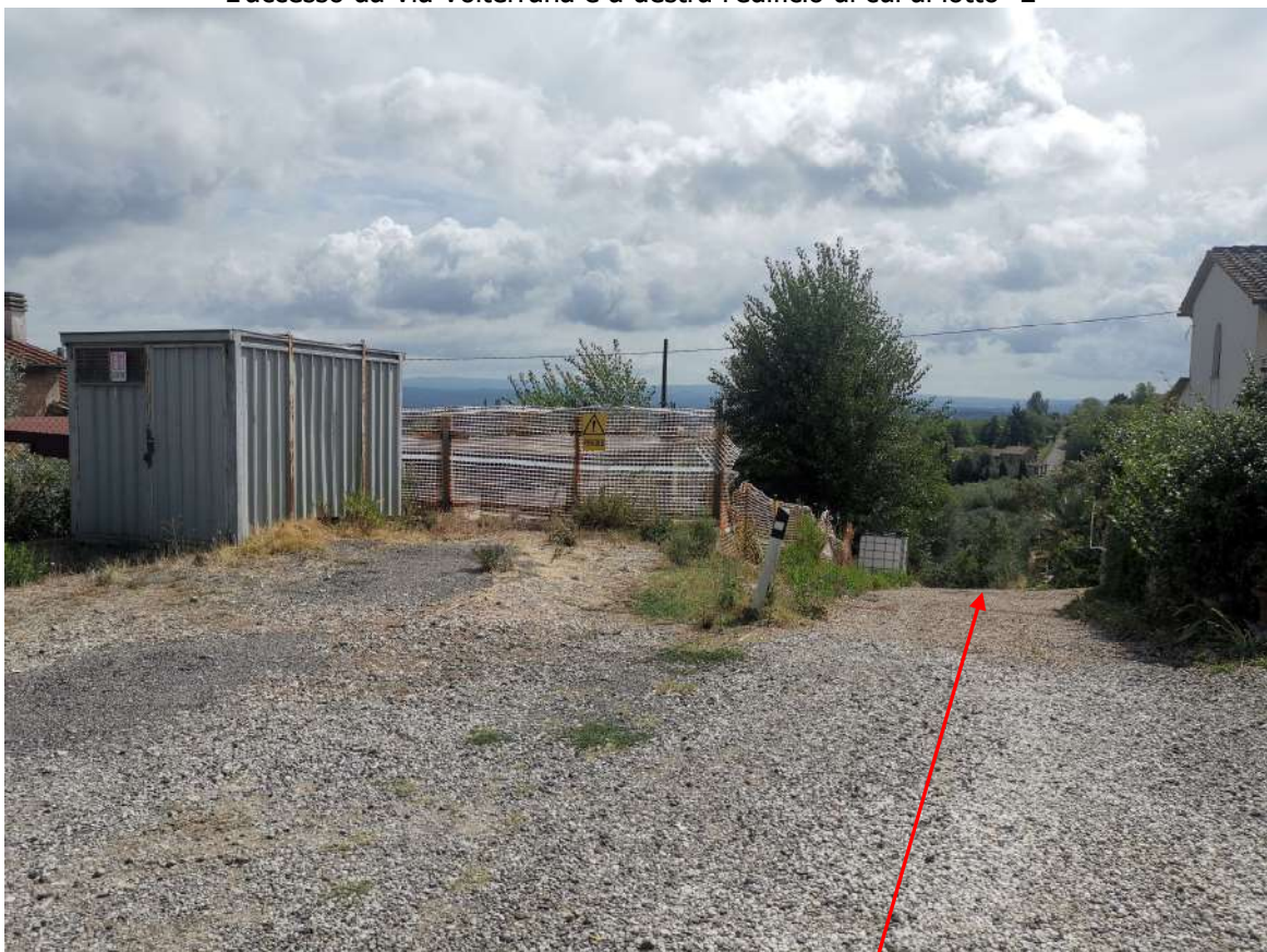
Foto n. 8 _ Sopralluogo del 02/09/2025 I terreni oggetto di esecuzione, a sinistra, al confine con la recinzione di cantiere (zona annesso in lamiera) le particelle 757 e 734 e a diritto, in pendenza, la prosecuzione della viabilità (particelle 755 e 738)
