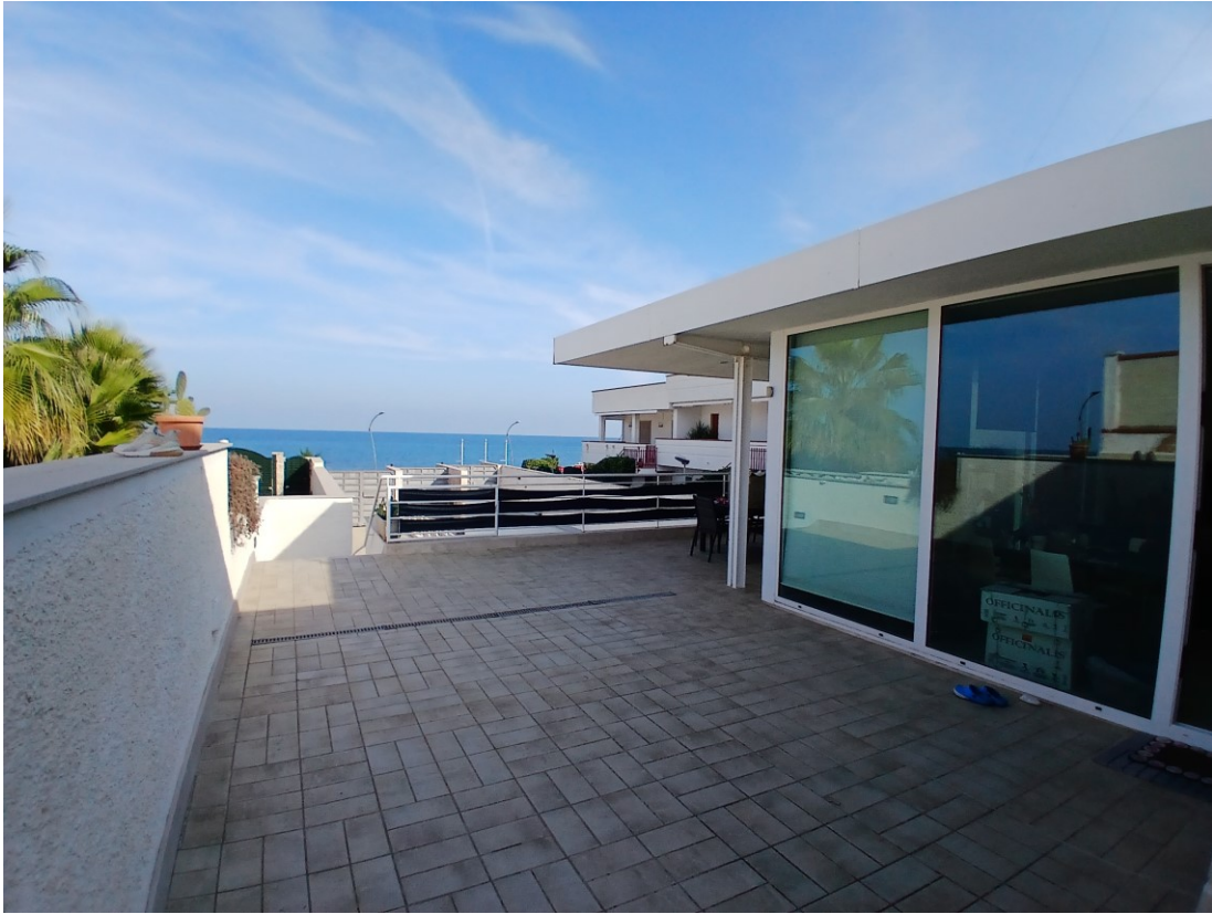
Foto 5 Vista Esterna Loggiato primo piano
