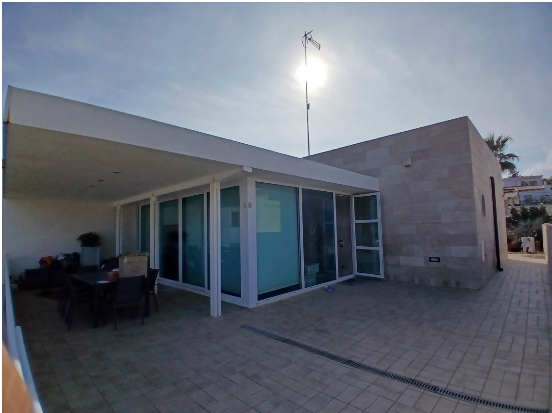
Foto 6 Vista Esterna Veranda, Soggiorno primo piano
