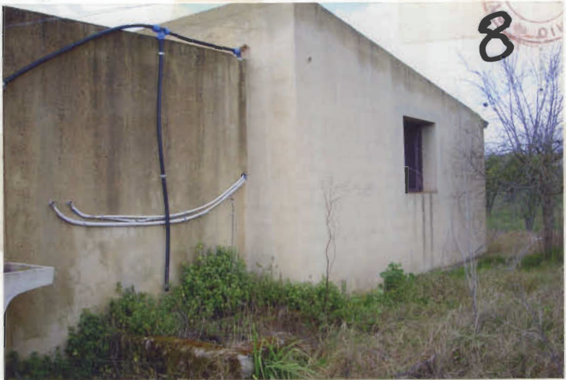
Prospetto laterale del fabbricato
