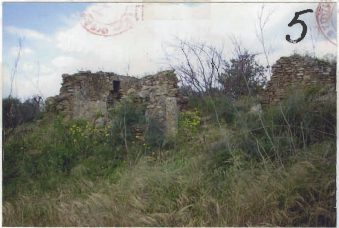
Ruine del fabbricato
