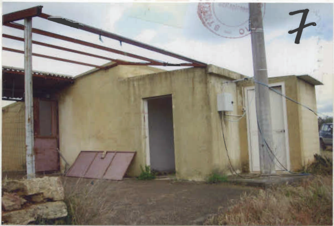
Prospetto del fabbricato realizzato
