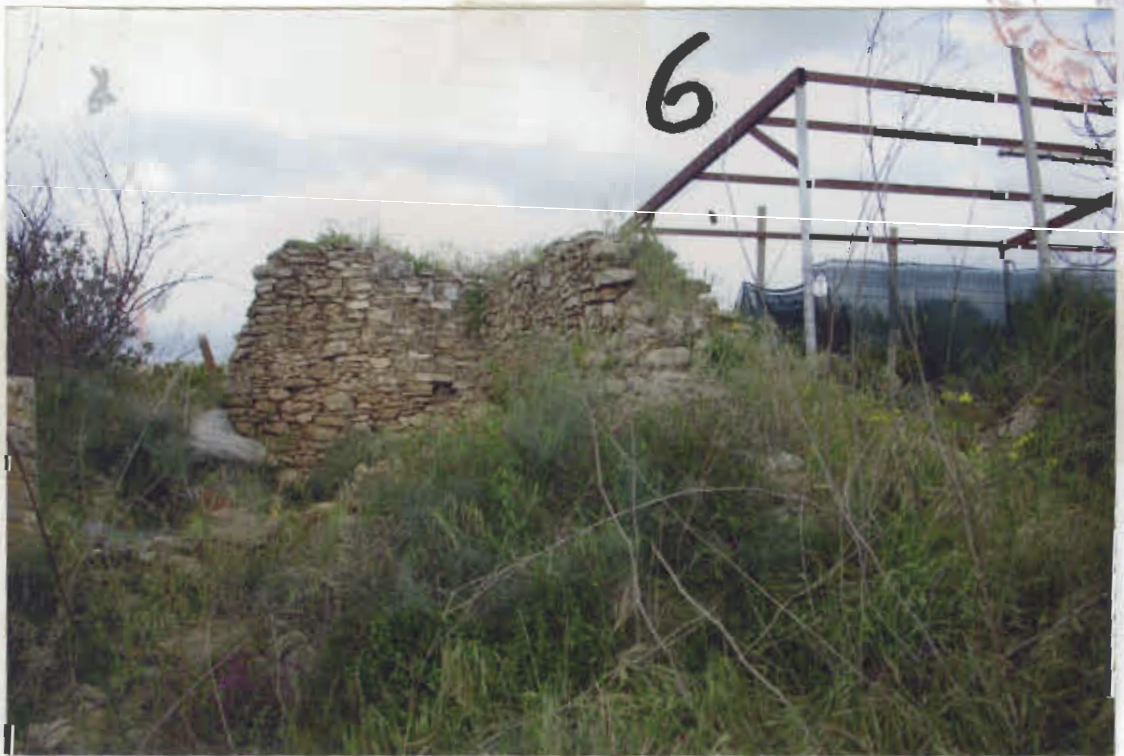
Ruine del fabbricato
