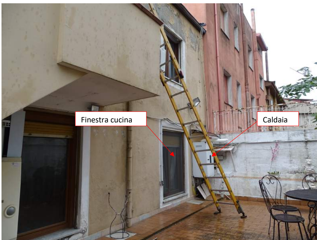
Foto 14 – Vista del cortile sul lato nord del fabbricato
