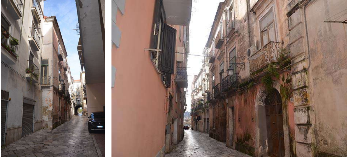
imm2.03: viste del fabbricato dalla strada
