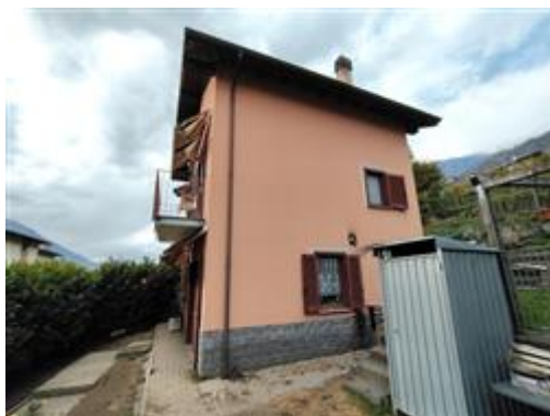
F.3_VISTA ESTERNA DEL FABBRICATO PARTICELLA 555
