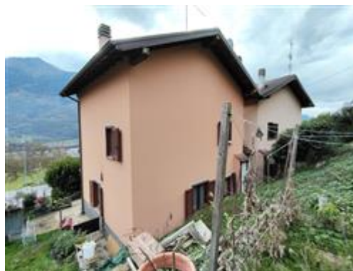
F.4_VISTA ESTERNA DEL FABBRICATO PARTICELLA 555
