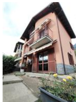
F.2_VISTA ESTERNA DEL FABBRICATO PARTICELLA 555
