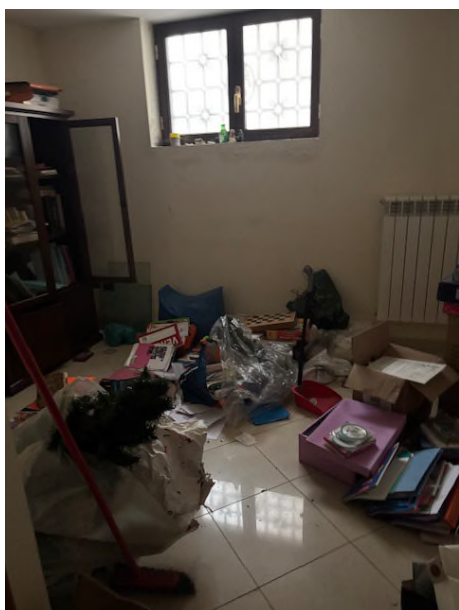
STANZA ADIACENTE AL DEPOSITO
