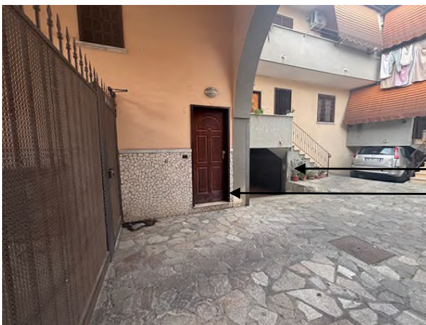
PORTONCINO DI INGRESSO E ACCESSO CARRABILE
