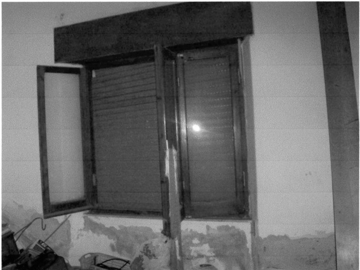
Stato di manutenzione degli infissi
