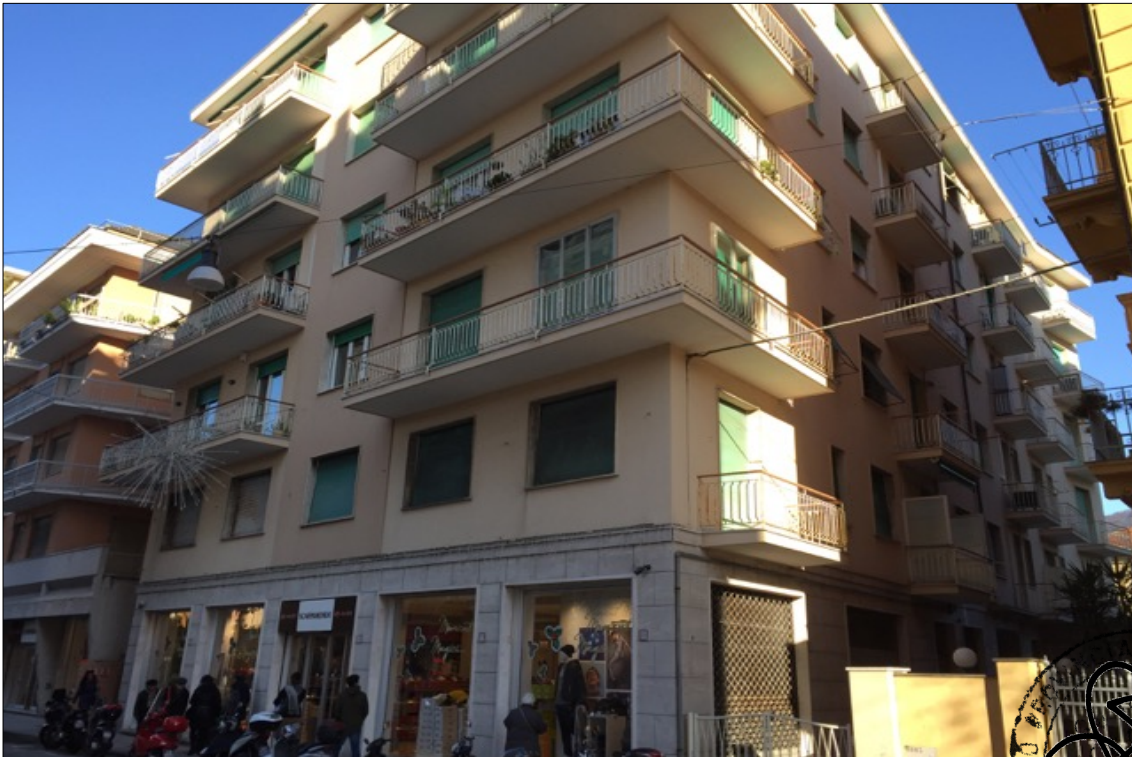
FOTO N° 4: Panoramica esterna immobile Corso Assereto 85.
