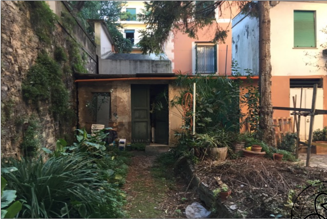
FOTO N° 1: Vista esterna magazzino Piazza dei Molino 5.
