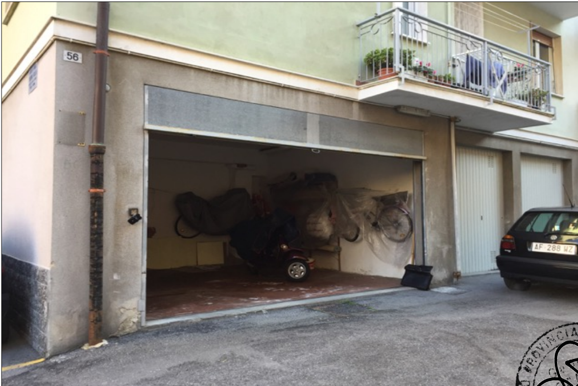
FOTO N° 28: Particolare di cui alla foto precedente .
