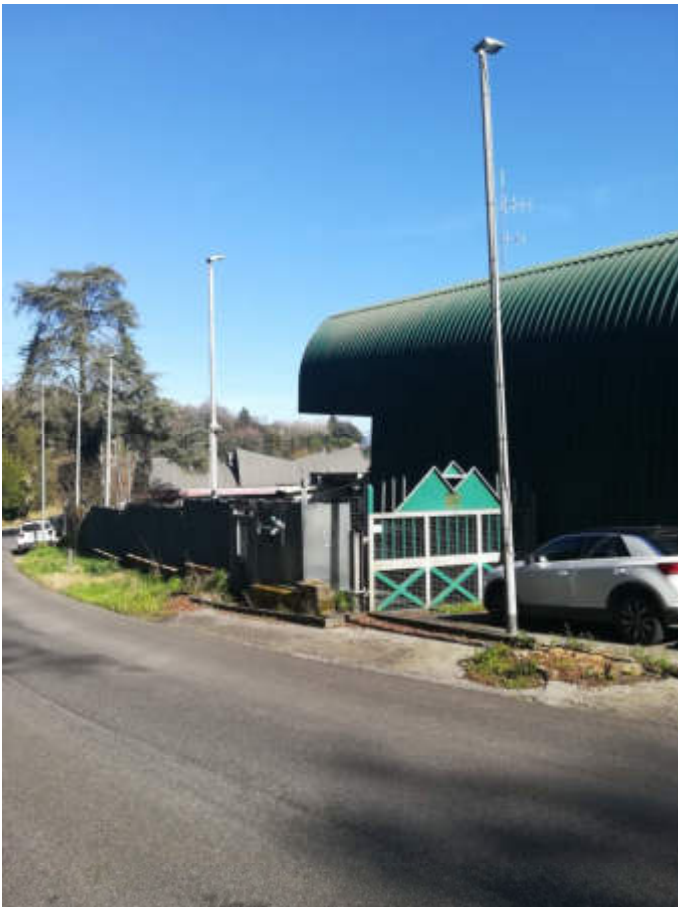
Foto 3, 4 e 5 – Vista esterna ed accesso da via Tiberina
