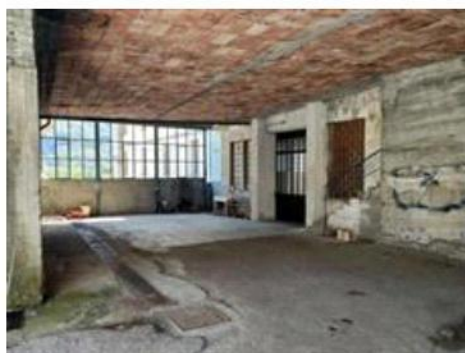
Porzione ovest del mappale 744 coperta in parte da una soletta laterocementizia ed in parte da una tettoia in eternit.
