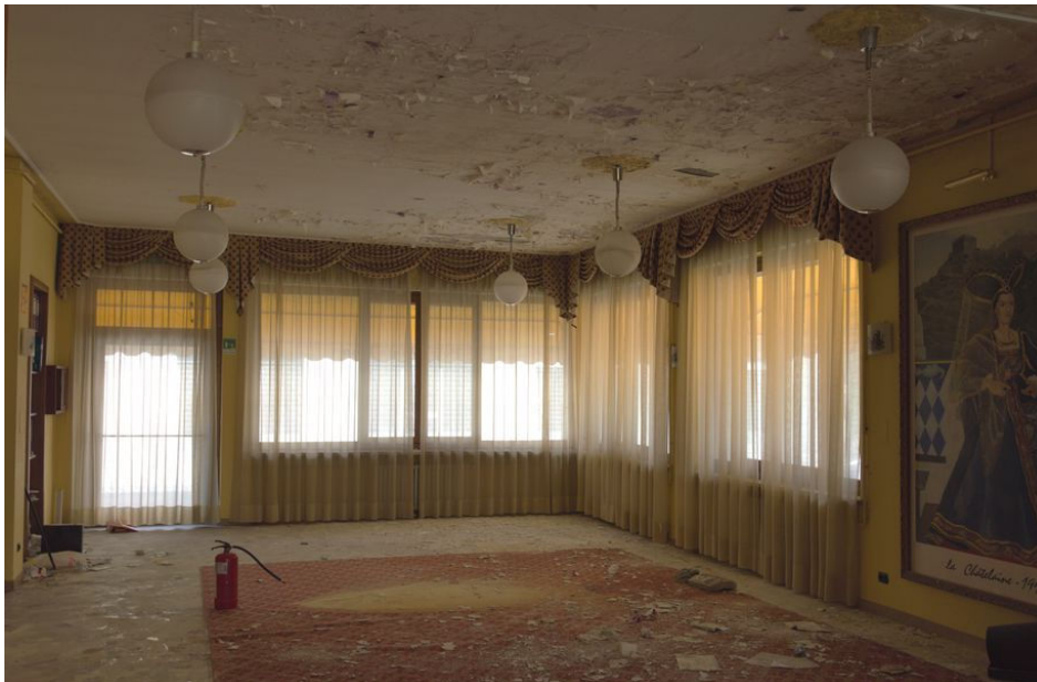
Illustrazione 7: Sala ristorante posta al piano terra. Si evidenziano diffuse esfoliazioni dello strato corticale interno dell'intradosso del solaio superiore. Emergono altresì segni di atti vandalici (svuotamento per terra del contenuto dell'estintore)
