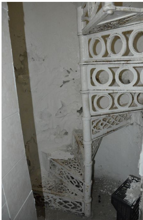
Illustrazione 13: Scala a chiocciola metallica che collega la cucina alla cantina formaggi. Si evidenziano diffuse esfoliazioni degli intonaci.
