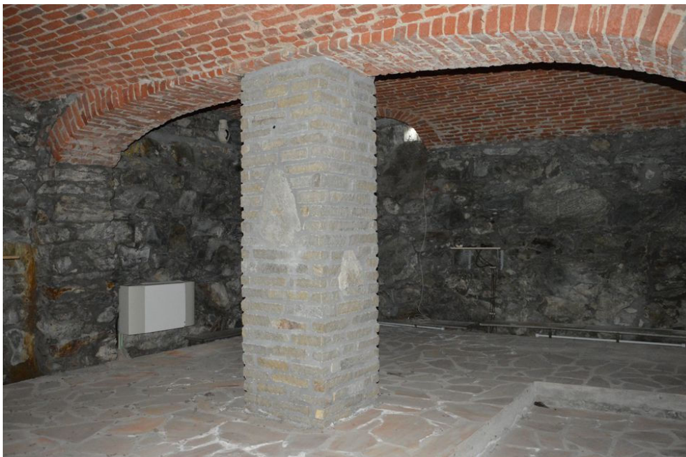
Illustrazione 18: Locale posto al piano seminterrato che all'interno della planimetria catastale è stato denominato "caveau". Si evidenzia la struttura in muratura portante in pietra con volte in laterizio apparentemente integre.
