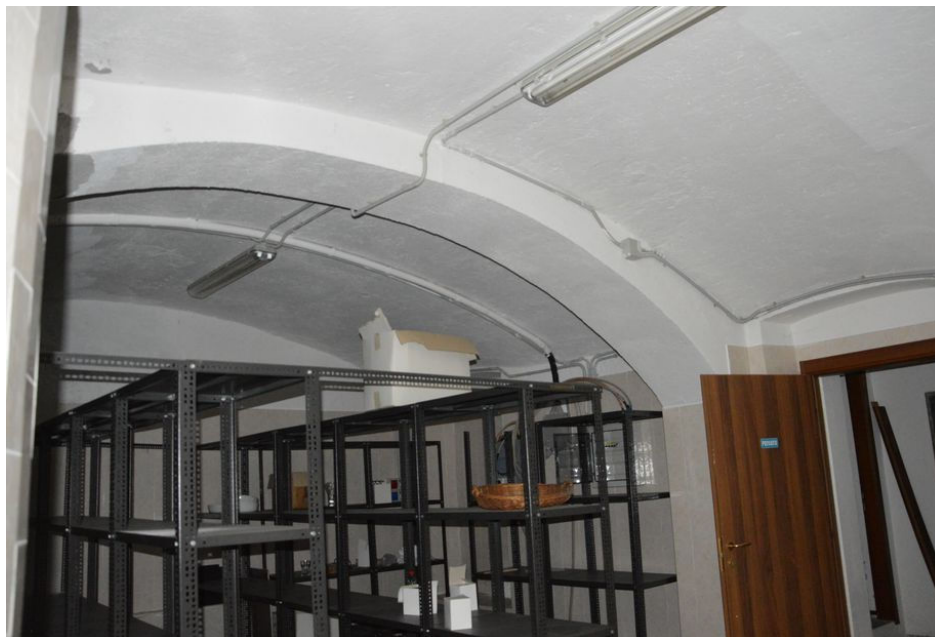
Illustrazione 14: Cantina formaggi posta al piano seminterrato.
