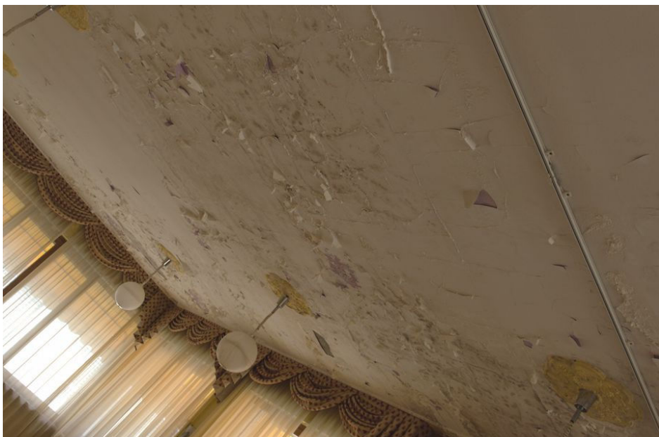
Illustrazione 8: Sala ristorante: particolare del livello di degrado riscontrato in relazione al solaio posto a copertura della sala. Emergono diffuse esfoliazioni e diffuse tracce di muffa che suggeriscono la presenza di infiltrazioni provenienti dall'estradosso.
