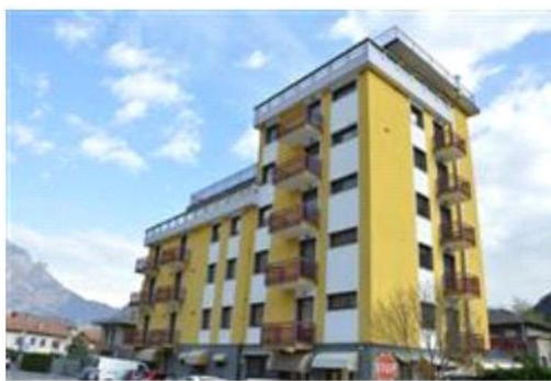
Fronti sud-est del fabbricato di cui fa parte il ristorante oggetto di esecuzione.
