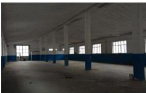
Interno del capannone, zona wc e uffici situati in prossimità dell'accesso posto sul fronte est.
