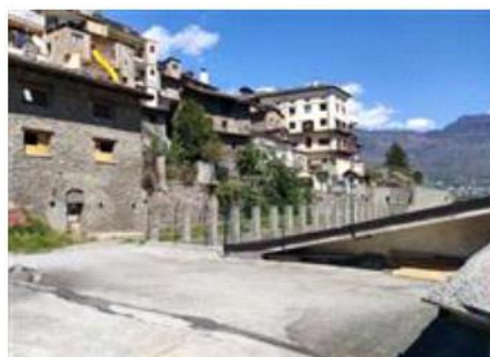
Estradosso della soletta di copertura della porzione ovest del mappale 744 attraverso la quale si accede al terrazzo di copertura dell'edificio sito sul mappale 376.
