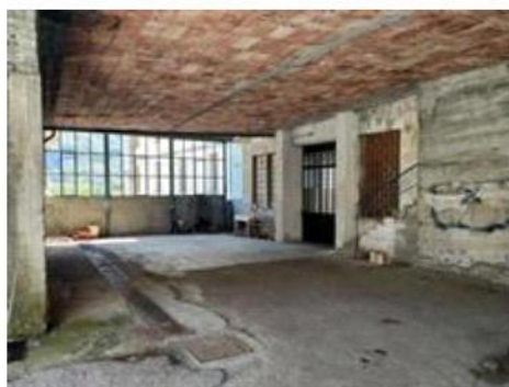
Porzione ovest del mappale 744 coperta in parte da una soletta laterocementizia ed in parte da una tettoia in eternit.
