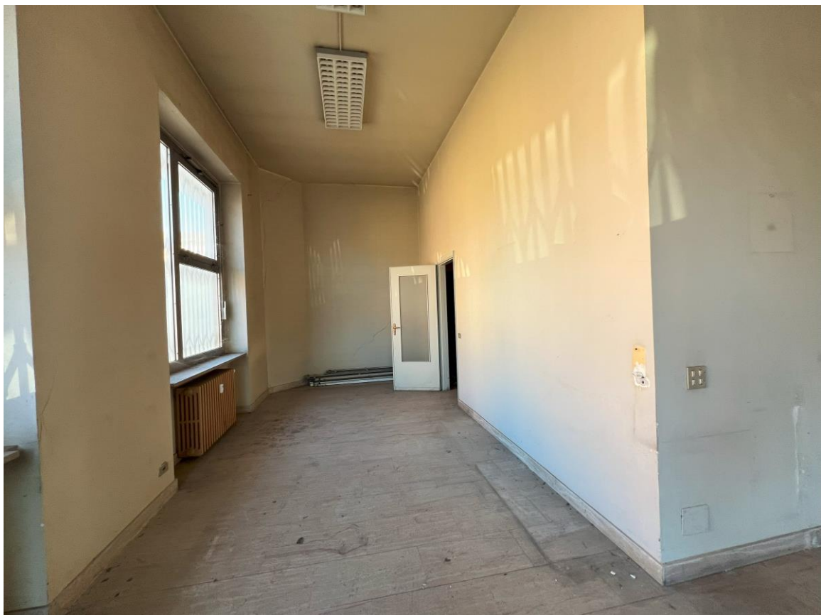
Foto 13. - Vista del locale
