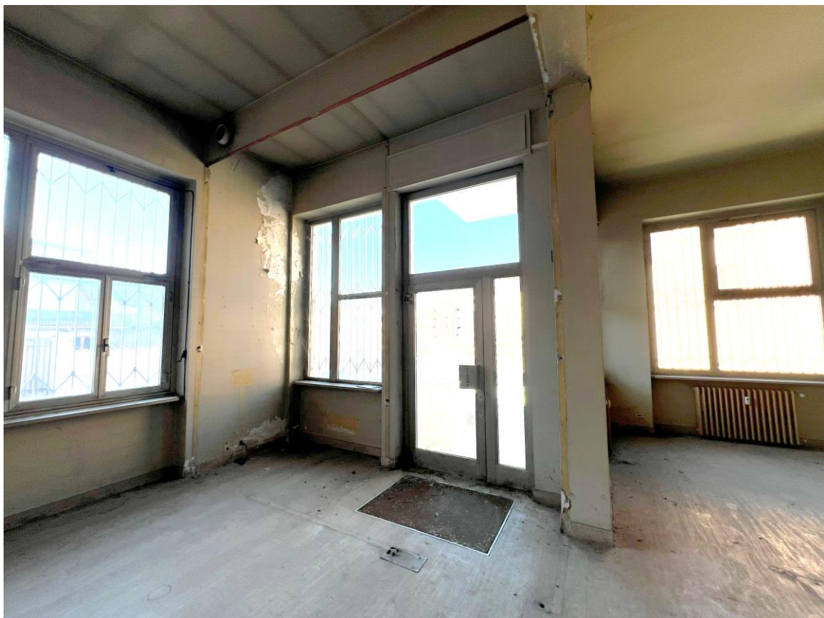
Foto 5. - Vista zona di ingresso
