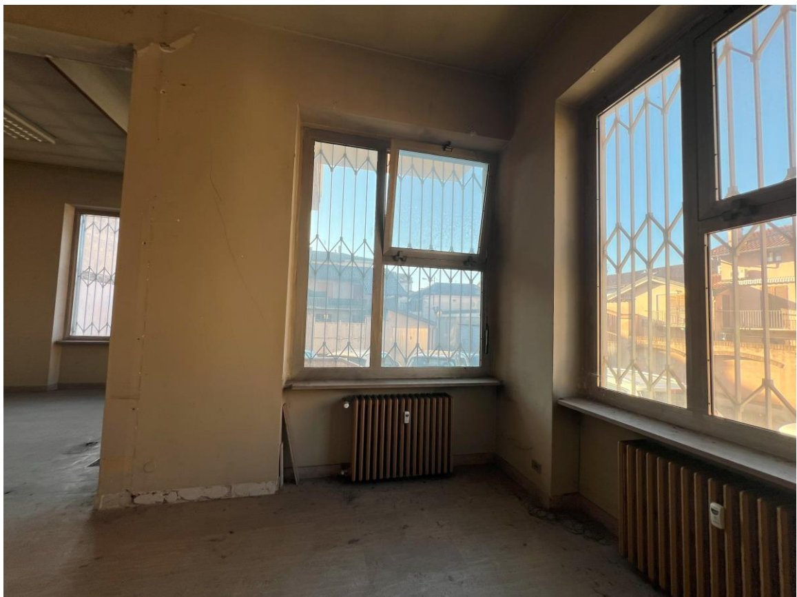
Foto 11. - Vista del locale
