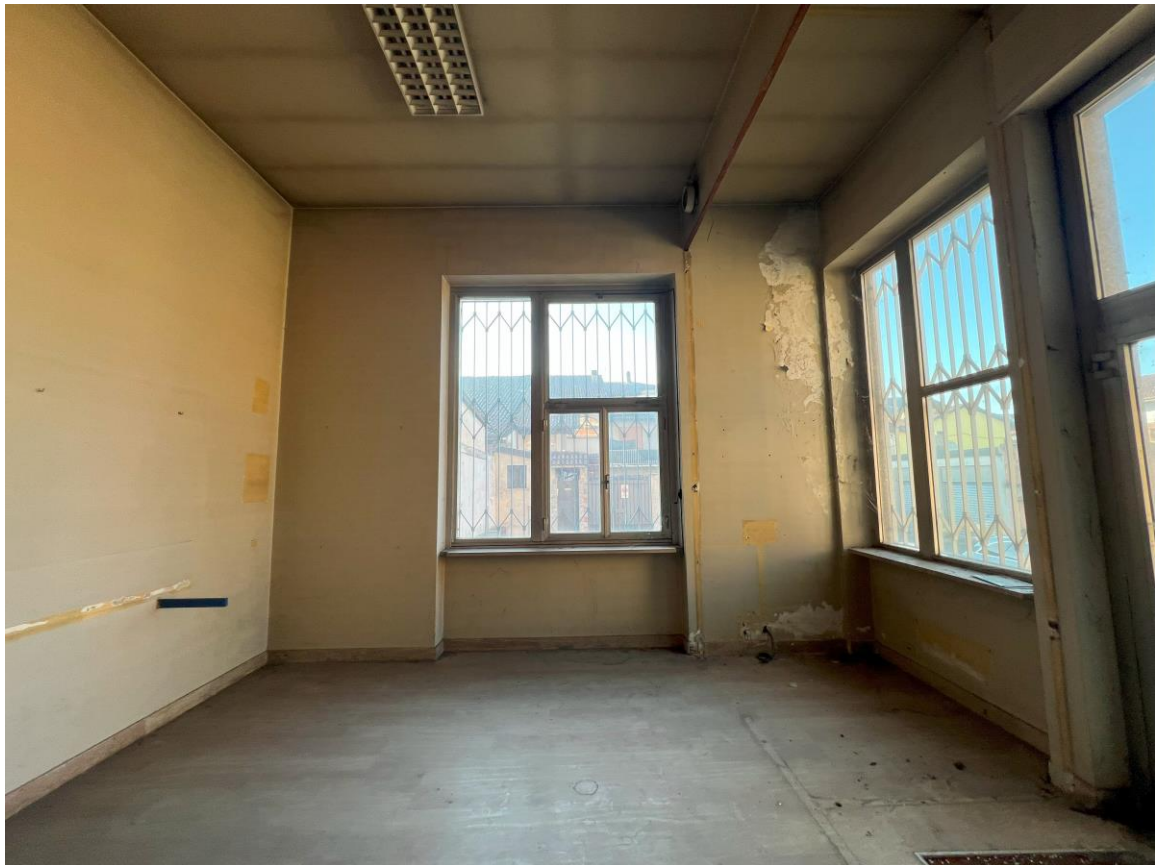
Foto 6. - Vista zona di ingresso
