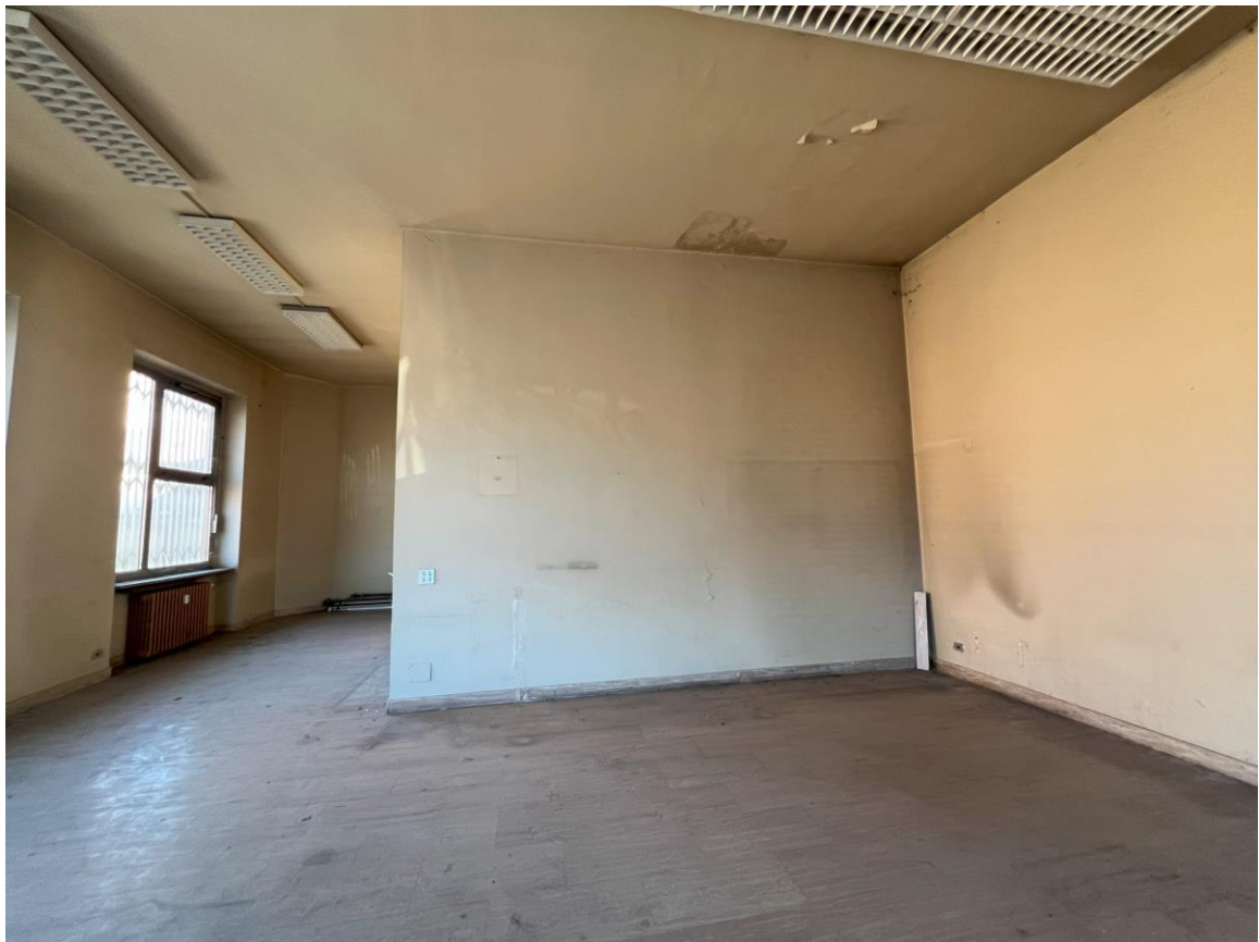
Foto 9. - Vista del locale
