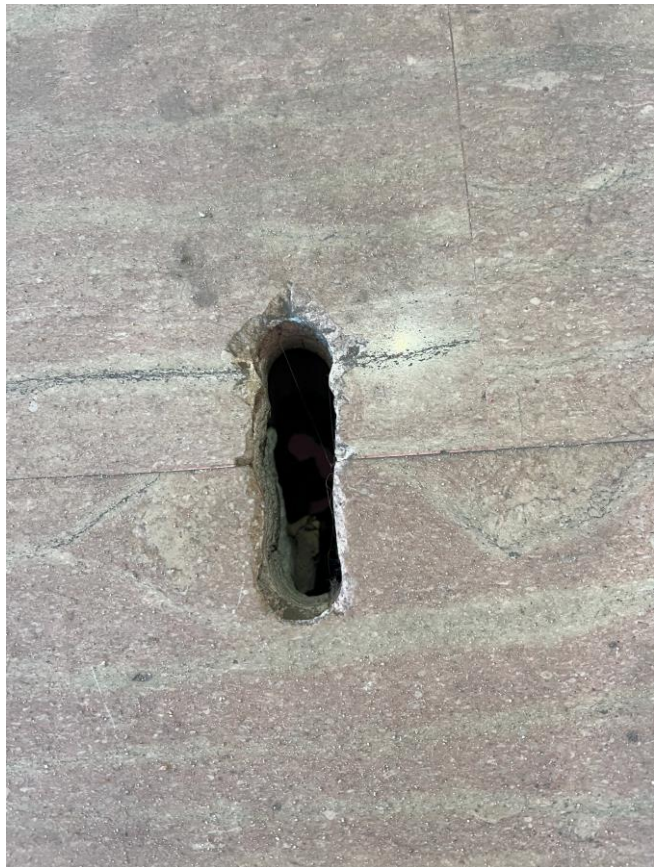
Foto 22. - Particolare fori a pavimento per passaggio cavi
