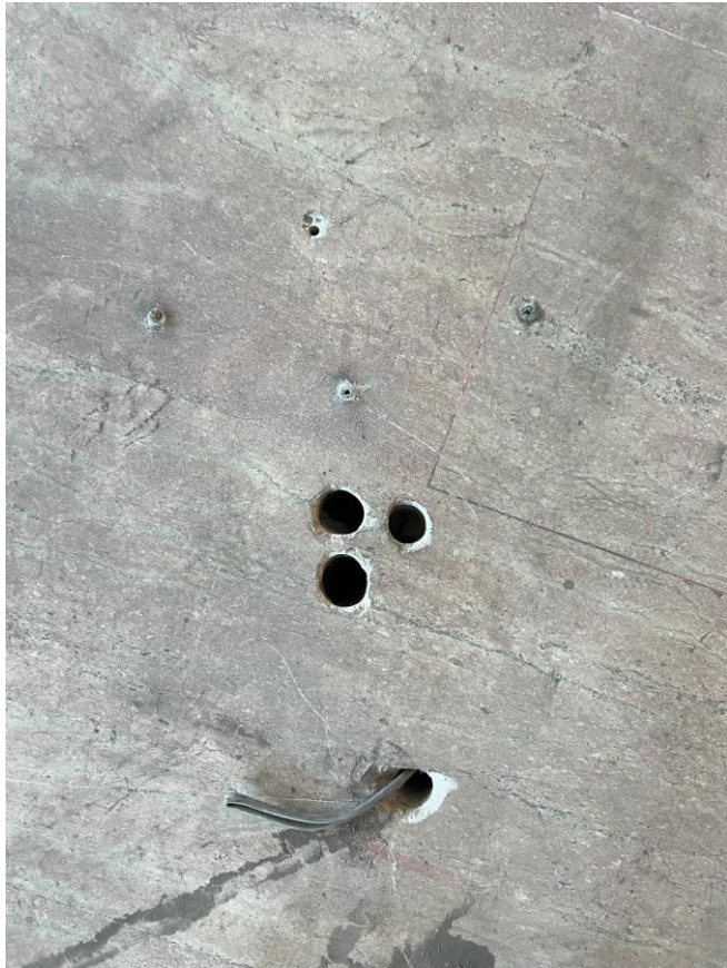
Foto 21. - Particolare fori a pavimento per passaggio cavi
