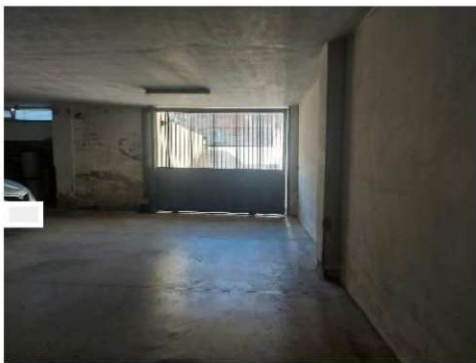
uscita da area interrata
