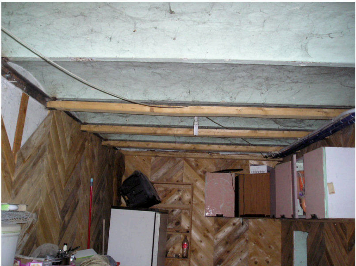
FOTOGRAFIA 08 - Locale di Sgombero P.T.
