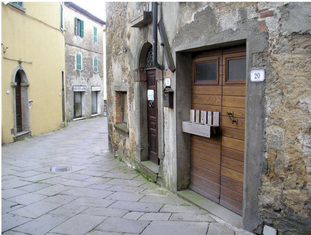
FOTOGRAFIA 03 - Ingressi Piano Terra
