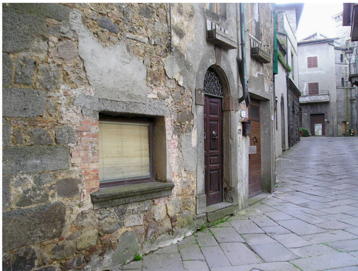
FOTOGRAFIA 04 - Ingressi Piano Terra
