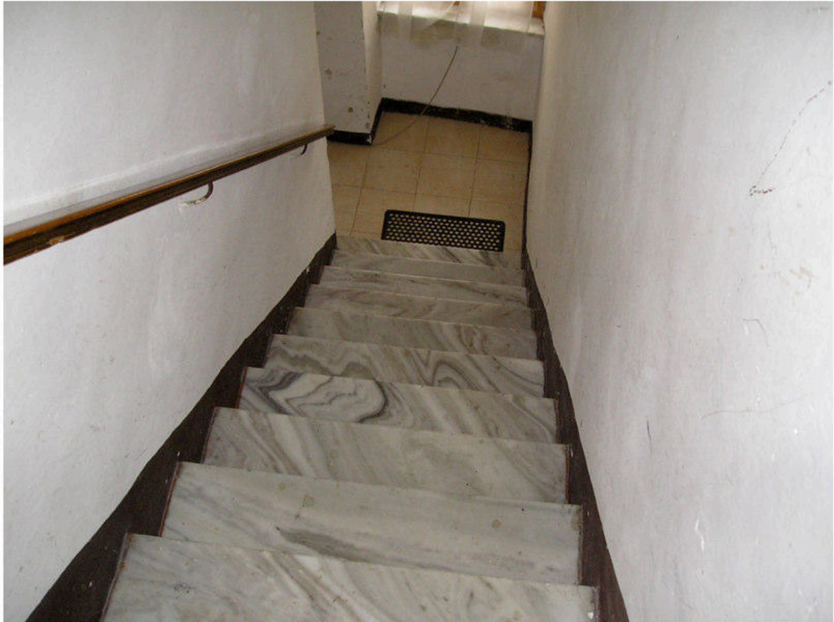
FOTOGRAFIA 21 - Scala Comune verso P.2
