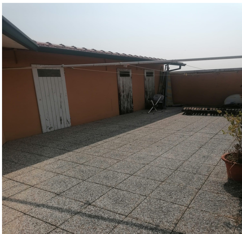
terrazza comune in copertura
