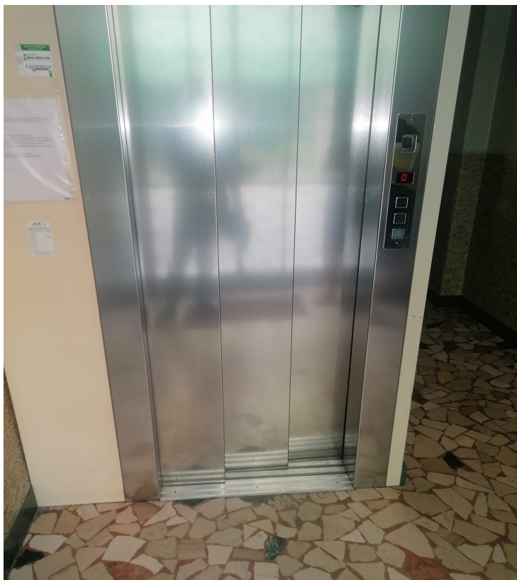
vano scale comune , porta ascensore
