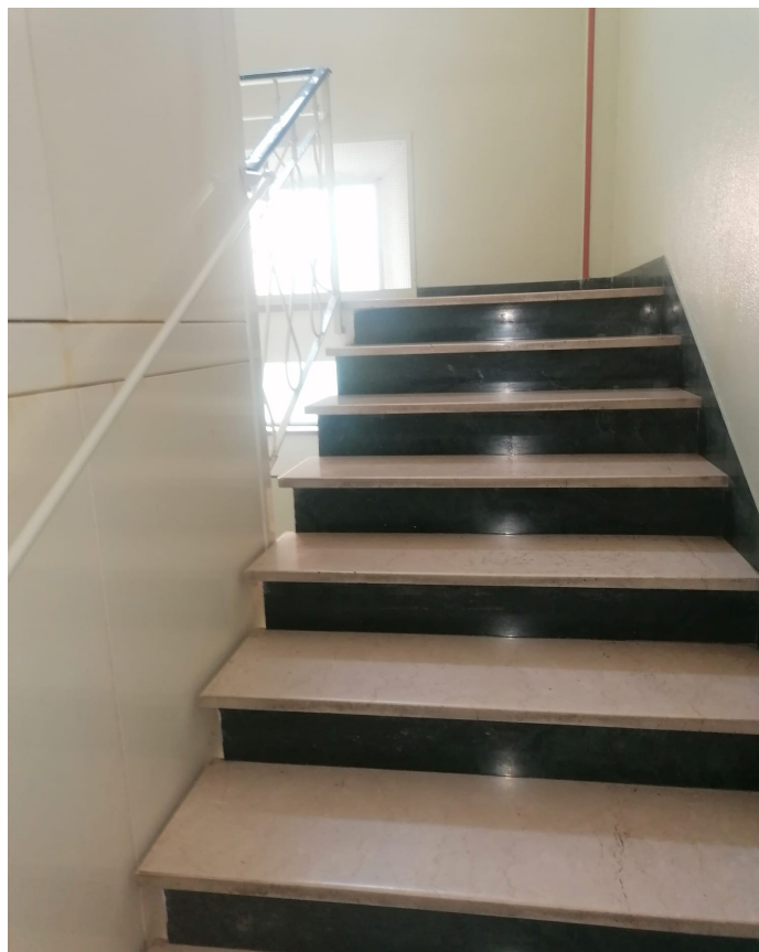
scala comune per accesso alla terrazza in copertura
