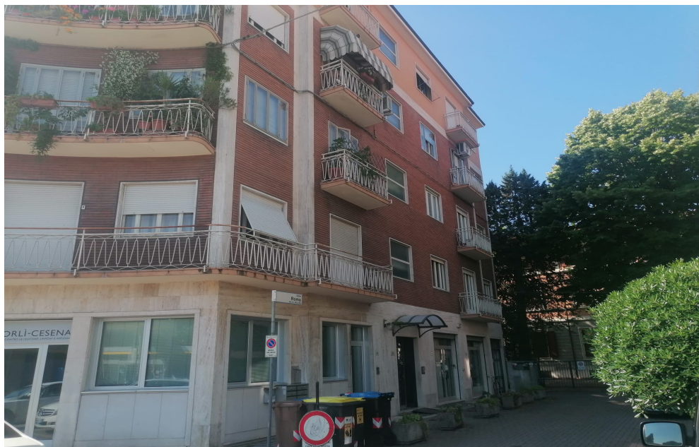
vista dell'immobile dal Viale Roma
