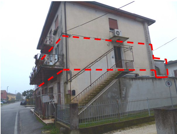
Foto 01 – Vista dalla strada lato Nord-Ovesta
