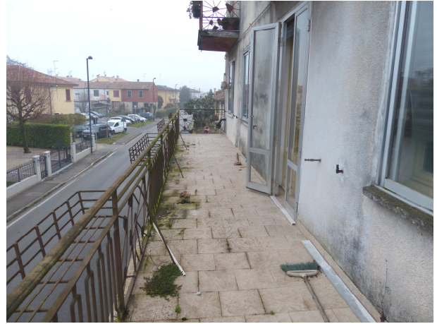
Foto 14 – Poggiolo fronte strada
