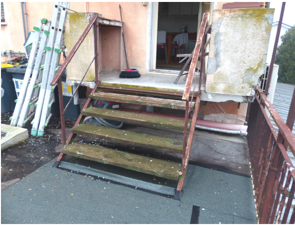
Foto 15 – Accesso alla terrazza
