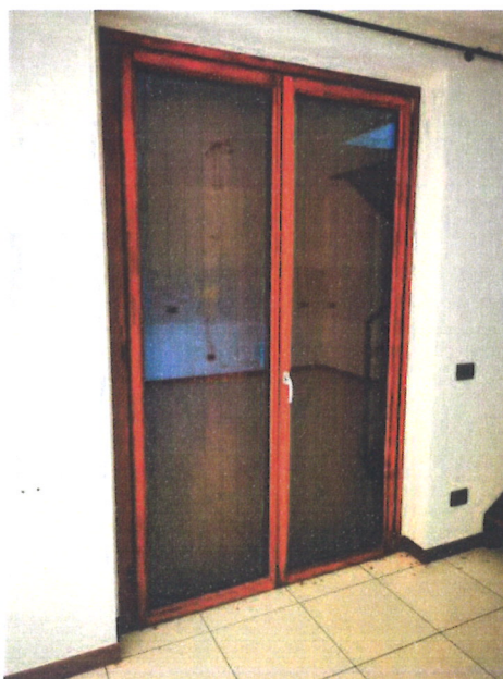
F.10 – Pavimenti e serramenti interni
