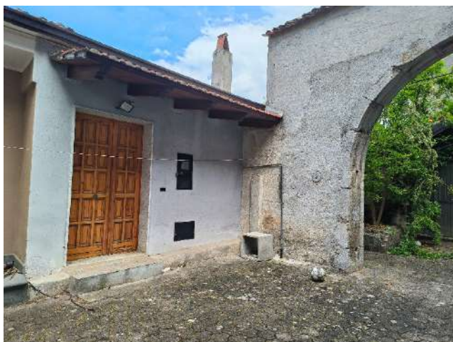
Figura 13: Particolare ingresso abitazione
