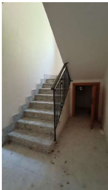
Figura 30: vista vano scala
