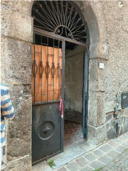
Figura 10: Particolare ingresso sa via Trinità
