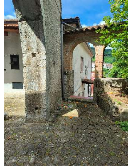
Figura 12: vista scala accesso laterali da corte comune
