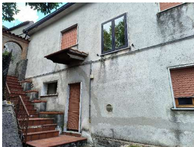
Figura 14: vista esterna da piano seminterrato
