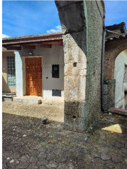
Figura 11: vista ingresso da corte comune
