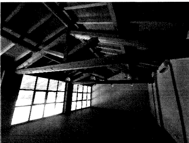
F.03 – Interno – Deposito
