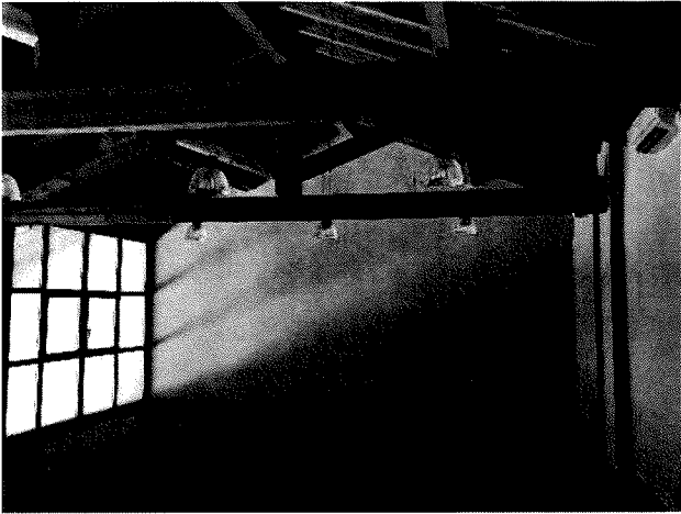
F.01 – Interno – Deposito
