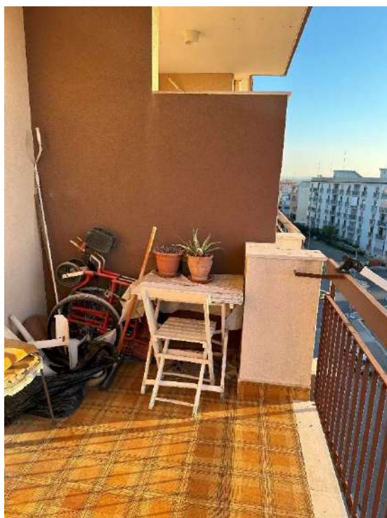
Figura 17: Balcone prospetto sud - ovest - 2
