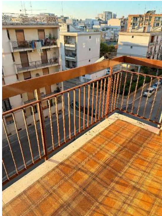
Figura 16: Balcone prospetto sud - ovest - 1
