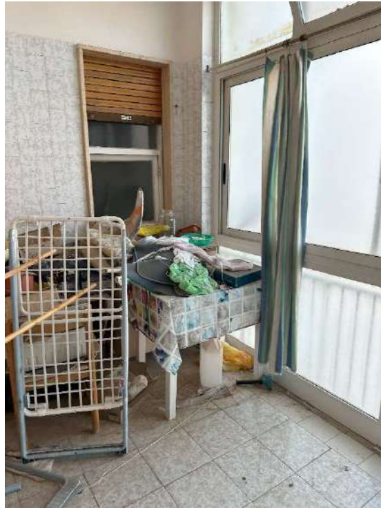
Figura 20: Balcone prospetto nord - est - 1
