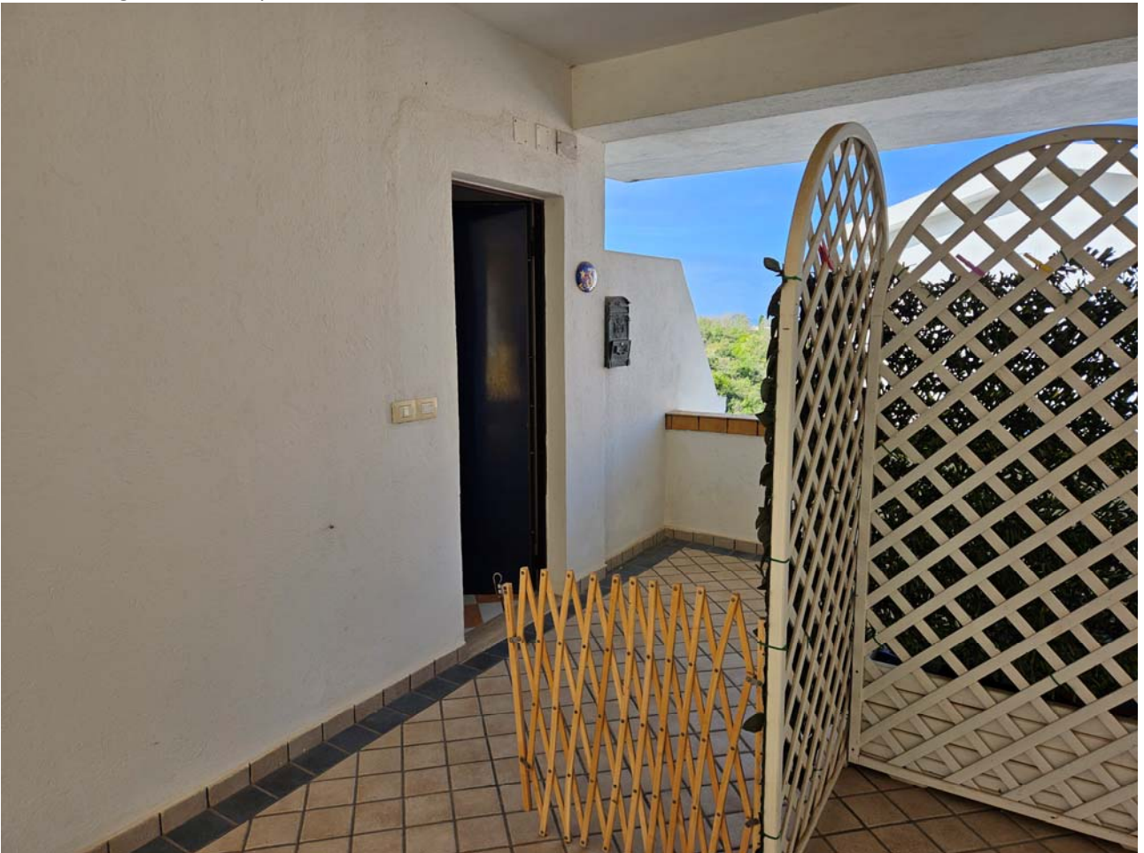
FOTO 04 ingresso dallo spazio comune
