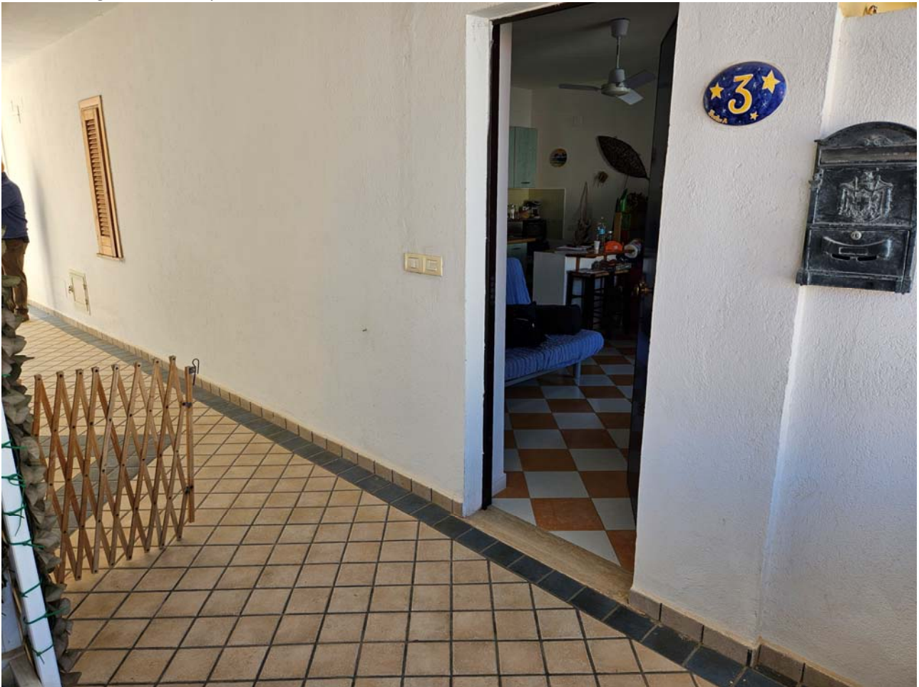
FOTO 05 ingresso dallo spazio comune
