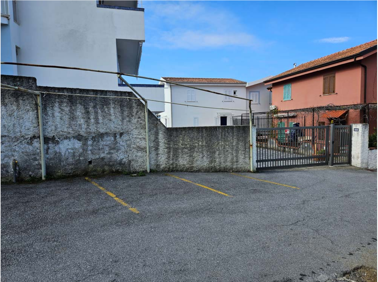
FOTO 01 esterno del fabbricato ingresso corte comune da cancello carrabile e pedonale
