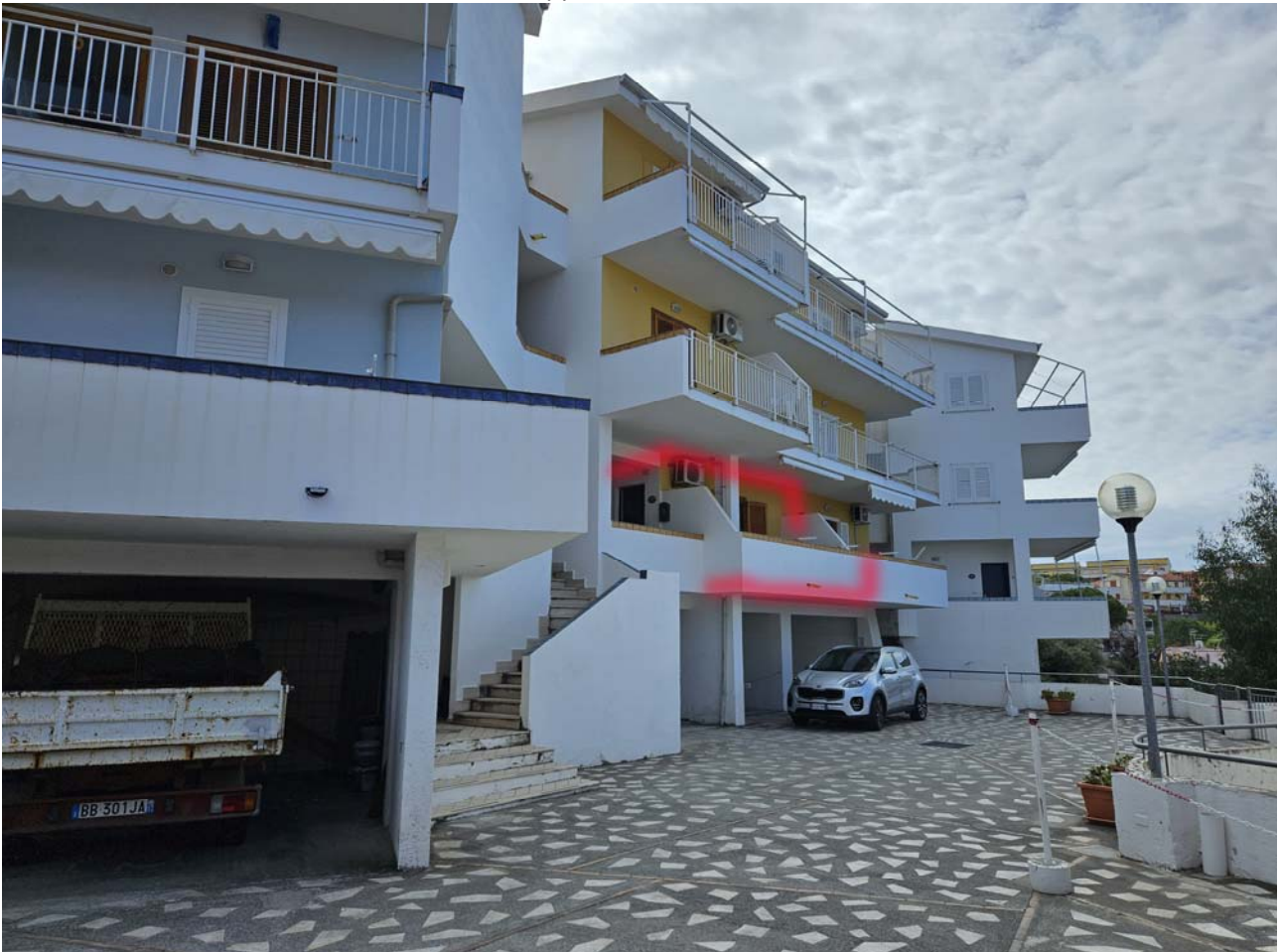
FOTO 02 esterno del fabbricato (tratto rosso appartamento)
