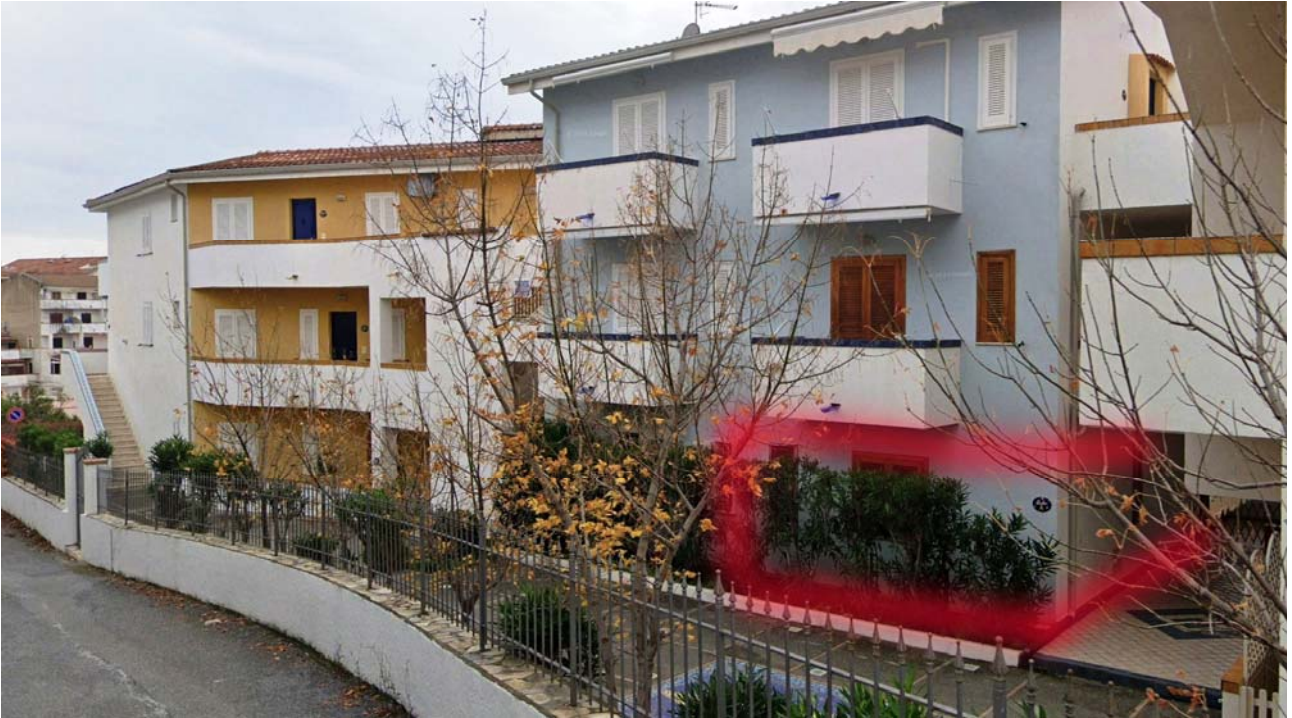
FOTO 03 esterno del fabbricato (tratto rosso appartamento)
