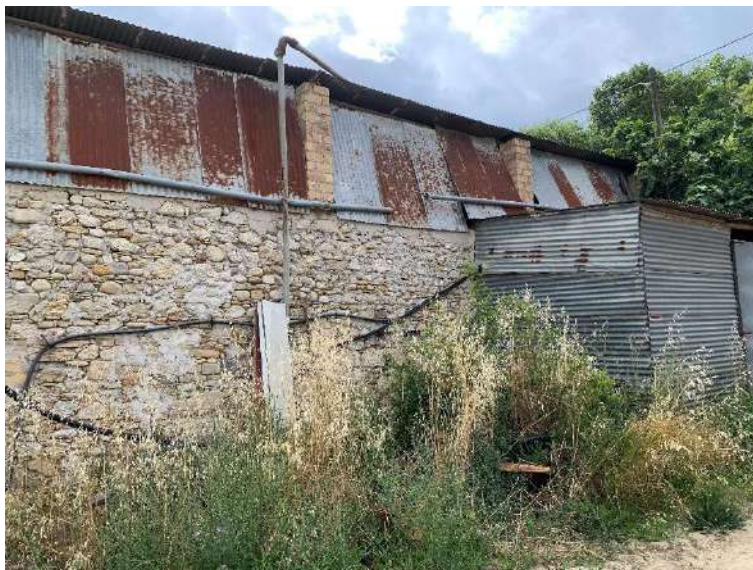
ACCESSORIO DEPOSITO PART 277 CORPO B
