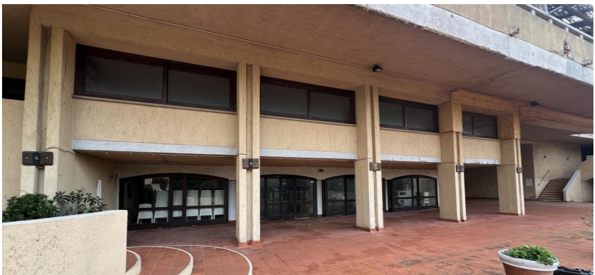
Figura 4 – vista frontale del bene
