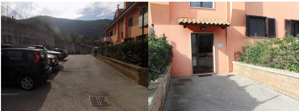
Foto 12-13: Altre riprese della corte interna sub.1 a servizio dell'intero fabbricato P.Illa 463, con particolare del portone Civ.23 di ingresso al vano scala che collega i vari livelli di piano. La Scala risulta priva di Impianto Ascensore (e configura barriera architettonica).
