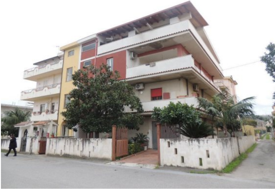
Ingresso da Via Alcide De Gasperi
